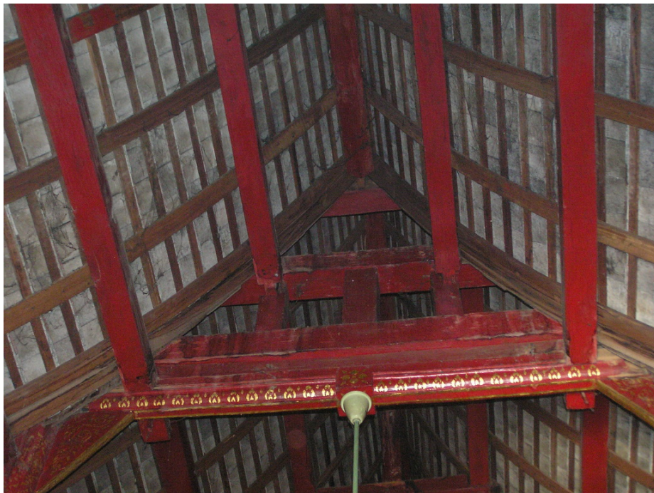
โครงสร้างหลังคาแบบไม้ต่างใหม่ภายในวิหารวัดพันแหวน
