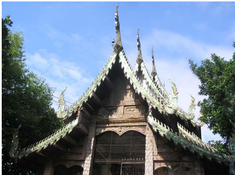
หน้าบันวิหารวัดพันแหวน แสดงโครงสร้างหน้าบันแบบมั่วต่างใหม่ตามแบบศิลปะล้านนา ที่โชว์โครงสร้างของซื่อและคาน
