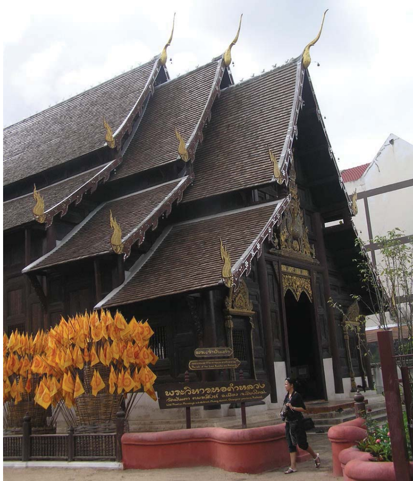
วิหารวัดพันเตา หลังคาด้านหน้าลดชั้นสองชั้น โครงสร้างก่อด้วยไม้ทั้งหลัง รวมทั้งผนัง หน้าบันโครงสร้างแบบม้าต่างใหม่
