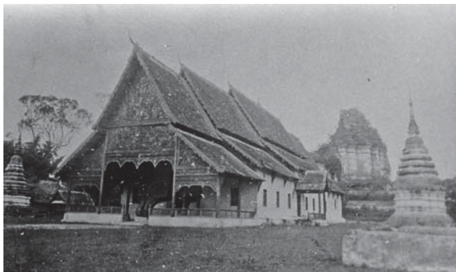
ภาพถ่ายเก่าวิหารวัดเจดีย์หลวงก่อนการบูรณะโดยเจ้าแก้วนวรรฐ เมื่อ พ.ศ. 2477
