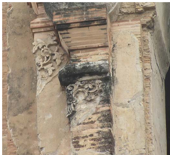
ภาพถ่ายลวดลายปูนปั้นกาบบนที่เสารับซุ้มจระนำเจดีย์หลวงด้านทิศเหนือ แลเห็นลายพันธุ์พฤกษาที่เป็นใบไม้
