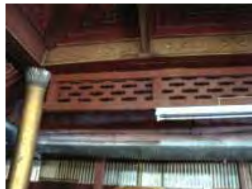
ภาพ 3-33 ช่องลมแกะสลักด้วยไม้ ลวดลายแบบไทใหญ่ใช้ตกแต่งเพื่อความสวยงามและระบายอากาศในอาคาร
