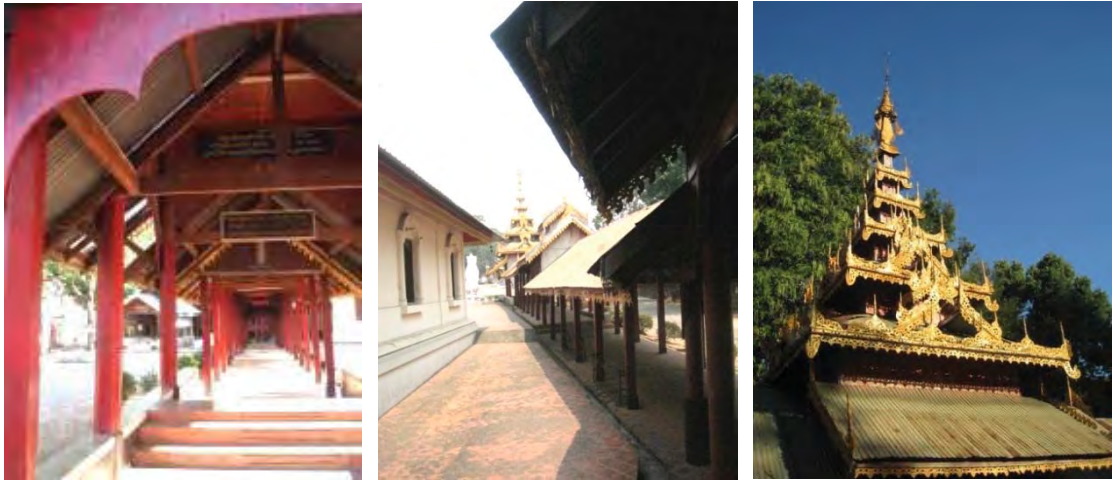
ภาพ 3-26 ชุมประตูทางเดิน (ล่าง) ก่อนเข้าสู่ศาลาการเปรียญคลุมด้วยหลังคาแบบสถาปัตยกรรมแบบไทใหญ่ ตกแต่งด้วยโลหะฉลุ
