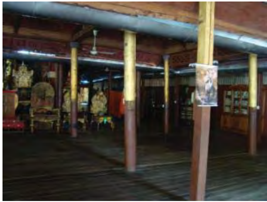
ภาพ 3-29 ศาลาการเปรียญเป็นโถงเปิดโล่งภายในแสดงโครงสร้างเสาไม้โดยพื้นที่ว่างภายในเชื่อมต่อกันโดยมีการยกระดับส่วนประกอบพิธีกรรมทางศาสนาแยกจากส่วนฆราวาส
