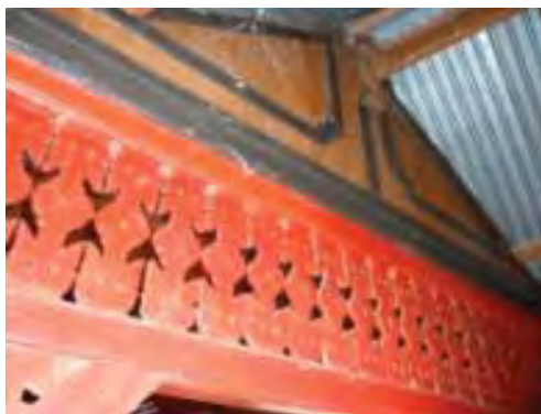
ภาพ 3-33 ช่องลมแกะสลักด้วยไม้ ลวดลายแบบไทใหญ่ใช้ตกแต่งเพื่อความสวยงามและระบายอากาศในอาคาร
