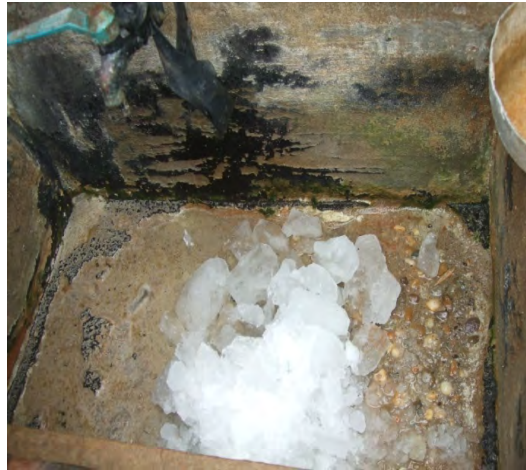
รูปที่ 25: วิธีใส่สารส้มแบบใหม่โดยใช้น้ำหยด
