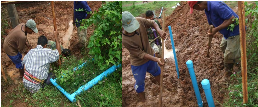
รูปที่ 29: นักวิจัยติดตั้งระบบแอร์แวน จุดที่ 1 บริเวณหน้าโรงเรียนบ้านห้วยใหญ่ประชาคม ติดตั้งเสร็จเวลา 13.35 น.
