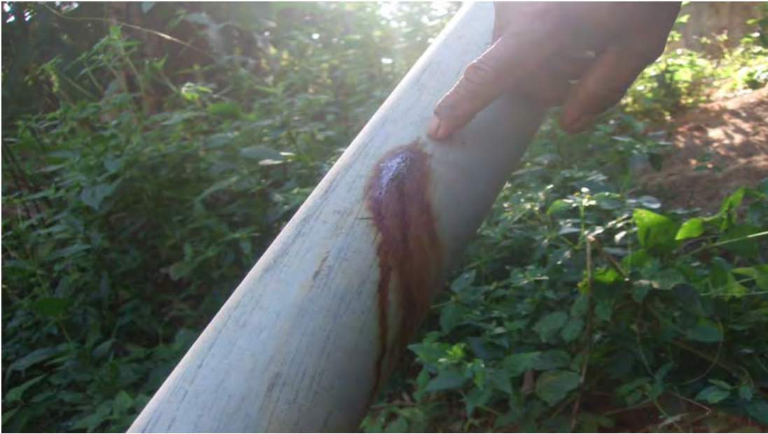
รูปที่ 5: ท่อส่งจากแหล่งน้ำดิบจุดที่ 3 ร้วซึม ซ่อมโดยการตัดแล้วต่อใหม่
