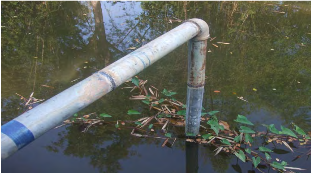
รูปที่ 4: ท่อที่ต่อเชื่อมกับหัวกะโหลก จุดที่ 2 ซ่อมโดยการตัดแล้วต่อใหม่
