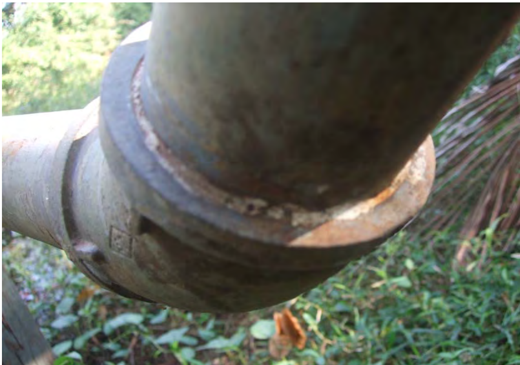
รูปที่ 6: ท่อส่งจากแหล่งน้ำดิบจุดที่ 3 ร้วซึม ซ่อมโดยการตัดแล้วต่อใหม่
