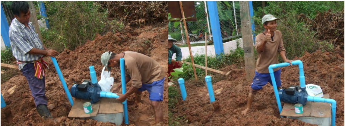
รูปที่ 33-34: ติดตั้งเครื่องสูบน้ำขนาด 3 แรงม้าหลังจากการติดตั้งแอร์แวงเสร็จเรียบร้อยแล้วทั้ง 3 จุด
