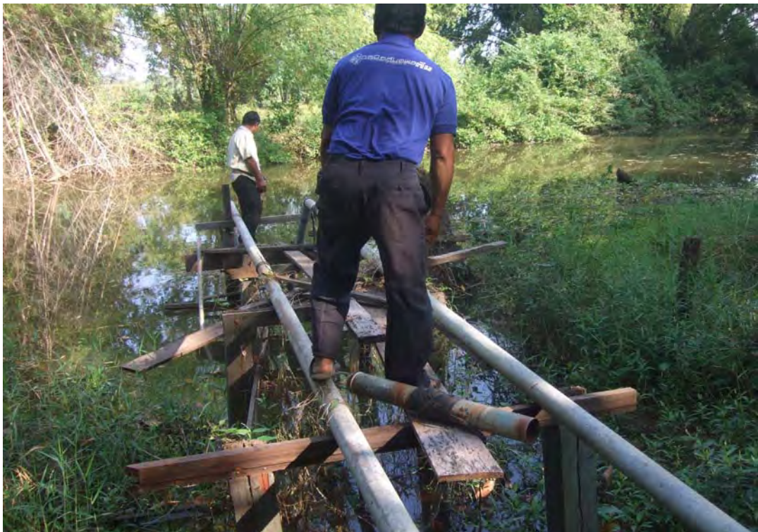
รูปที่ 2: นักวิจัยได้ทำการซ่อมที่หัวกะโหลกโดยการยกให้สูงขึ้นจากพื้นดินเพื่อไม่ให้โคลน และซากวัชพืชไหลเข้าไปในหัวกะโหลกของท่อประปา (21 สิงหาคม 2553)
