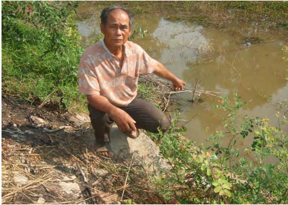
รูปที่ 71: จุดที่ท่อระบายน้ำใต้ถนนสายบ้านห้วยใหญ่-บ้านห้วยน้อยจากกุดมอญมากุดน้ำใส
