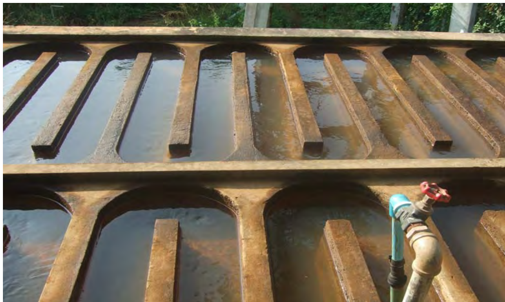
รูปที่ 8: ร่องน้ำวนอันเป็นอีกกระบวนการในการทำให้น้ำสะอาด หลังจากทีน้ำถูกสูบขึ้นมาจากแหล่งน้ำดิบต้องมาผ่านร่องน้ำวนก่อนการกรองในขั้นตอนต่อไป
