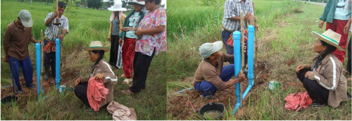
รูปที่ 31-32: บริเวณท่อระบายน้ำถนนสายสามพร้าว-ดอนกลอย ช่วงระหว่างสามแยกศาลหลักบ้าน กับโรงเรียนบ้านห้วยใหญ่ประชาคม ติดตั้งเสร็จเวลา 13.30 น.
