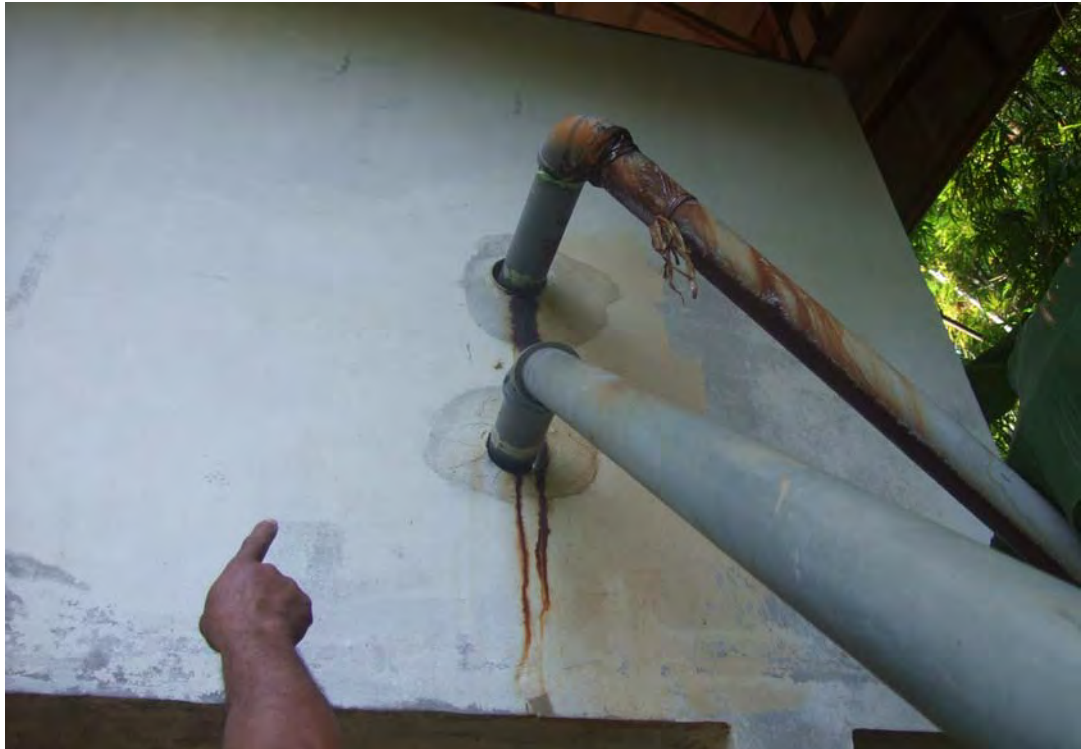
รูปที่ 7: ท่อส่งจากแหล่งน้ำดิบจุดที่ 3 ร้วซึม ซ่อมโดยการตัดแล้วต่อใหม่
