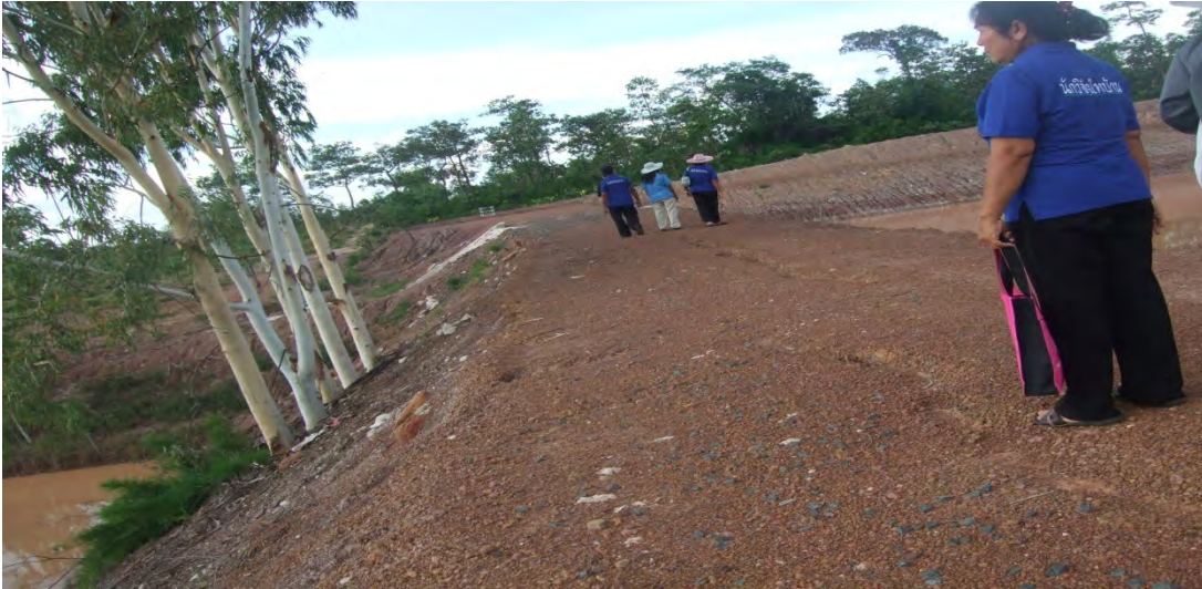
รูปที่ 20: อ่างเก็บน้ำบนที่สูงและมีระดับต่างกันเพื่อการปล่อยน้ำโดยไม่ต้องใช้เครื่องสูบน้ำเพื่อการประหยัดค่าใช้จ่าย
