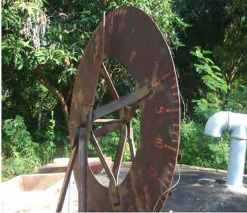
รูปที่ 75: เข็มวัดระดับถังพักน้ำใส
