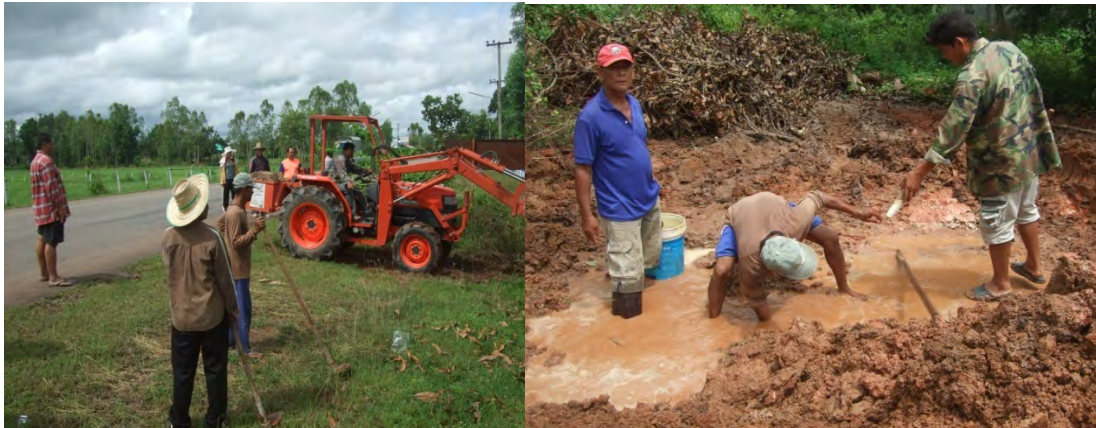
รูปที่ 28: นักวิจัยและชาวบ้านกำลังค้นหาท่อส่งน้ำสายหลักโดยใช้รถช่วยขุดปรากฏว่าพบท่อส่งน้ำดังกล่าว หลังจากที่ใช้กำลังคน
