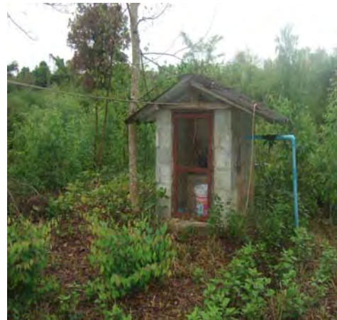
รูปที่ 74: ห้องเครื่องสูบน้ำ
