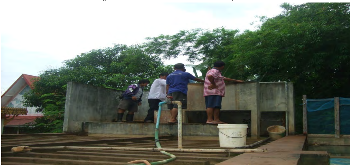
รูปที่ 23: นักวิจัยปรับเปลี่ยนระบบสารส้มจากที่เคยทำคือเอาสารส้มใส่ถุงตาข่ายที่ละหลายๆ กิโลกรัมแล้วจุ่มแช่น้ำ เป็นแบบหยดน้ำใส่สารส้มในถังรองสารส้มที่โครงสร้างจัดให้
