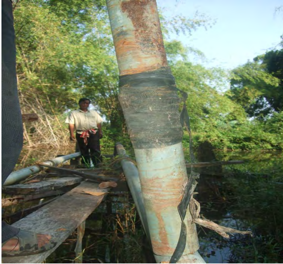
รูปที่ 3: ท่อส่งจากแหล่งน้ำดิบ จุดที่ 1 รั้วซึม ซ่อมโดยการตัดแล้วต่อใหม่
