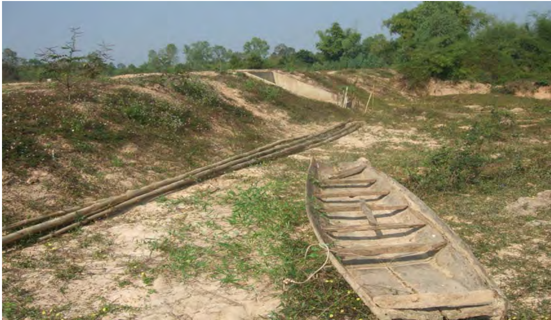
รูปที่ 72: ฝายน้ำล้นในปัจจุบันถูกปรับปรุงโดยการวางท่อระบายน้ำพร้อมกับบุงกะชะ
