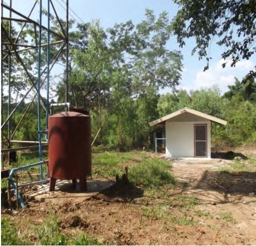
รูปที่ 42: หอถังและถังกรองน้ำประปาโรงเรียน
