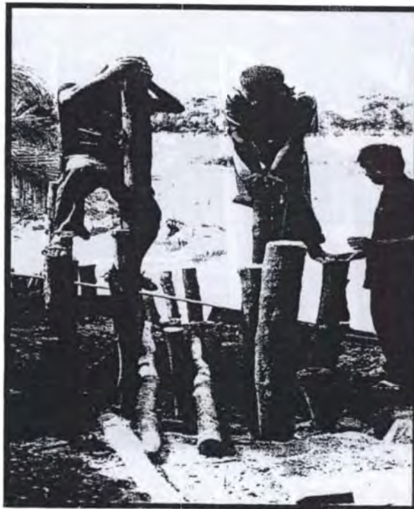
รูปที่ 13 ข คอกไม้สนทำฐานเพื่อสร้างที่ติดตั้งเครื่องกาลักน้ำ
