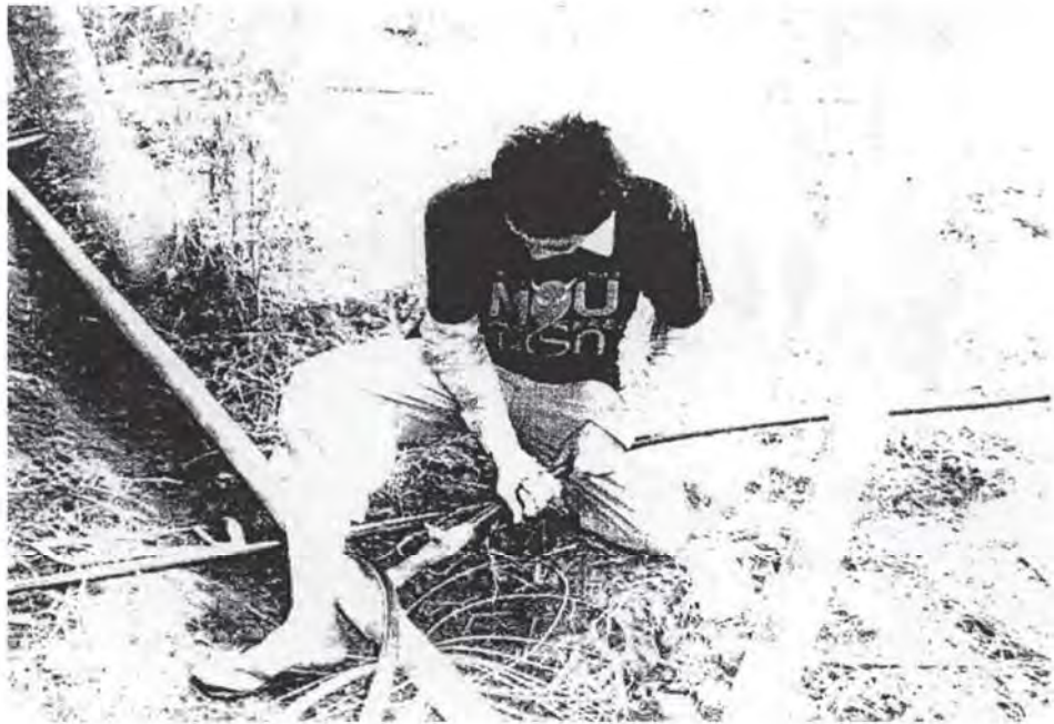
รูปที่ 17x วางระบบน้ำ ท่อพีและหัวฉีดมีแรงสปริงเกลอร์
