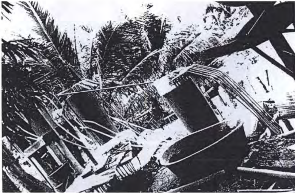
รูปที่ 14ข ติดตั้งเครื่องกาลักน้ำ
