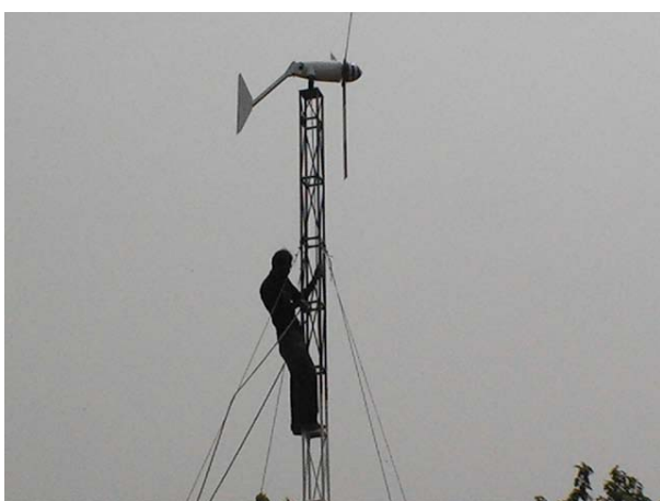
รูปที่ 167 เจ้าหน้าที่ทหารพราน BP 16 ปีนเสากังหัน ลมเพื่อตรวจสอบจุดยึดสลัก
