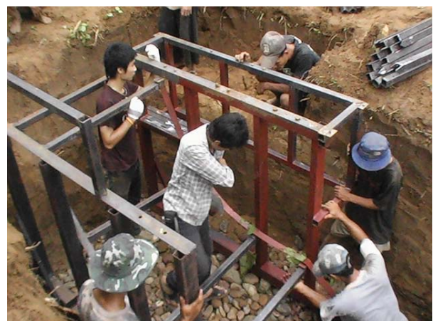
รูปที่ 212 ประกอบฐานวงล้อน้ำและปรับระดับ
