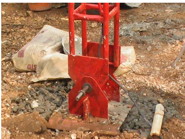
รูปที่ 165 โครงเสากังหันลมถูกยกตั้งบนฐานและ ยึดด้วยสลัก
