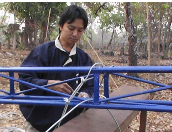
รูปที่ 161 ผู้ช่วยนักวิจัย ประกอบเสาเข็มดิน และ เตรียมติดตั้งยึดเสา
