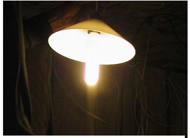
รูปที่ 170 ผลงานการติดตั้งระบบแสงสว่างที่ใช้ไฟฟ้าจากพลังงานลม
