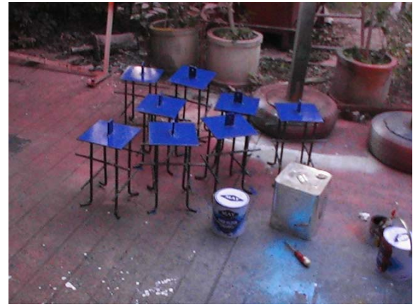
รูปที่ 142 จัดเตรียมทาสีฐานยึดสลิงของเสาган्हันลม
