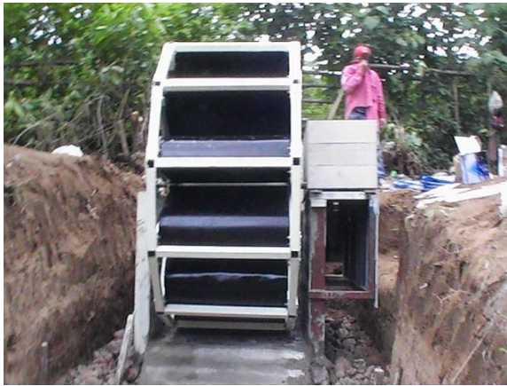
รูปที่ 231 วงล้อน้ำที่เทฐานเรียบร้อยแล้ว
