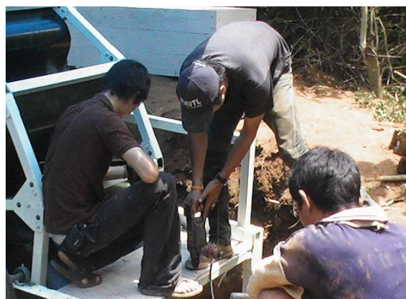
รูปที่ 222 ติดตั้งไม้เซอราเพื่อรองรับ Water intake
