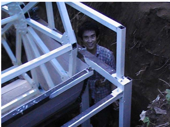
รูปที่ 219 ทาสีฐานวงล้อน้ำด้วยสีEpoxy Top Coat
