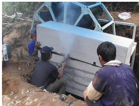
รูปที่ 226 ปิดฝาครอบและปรับแต่งฝาครอบชุด เฟืองโซ่และสายพาน
