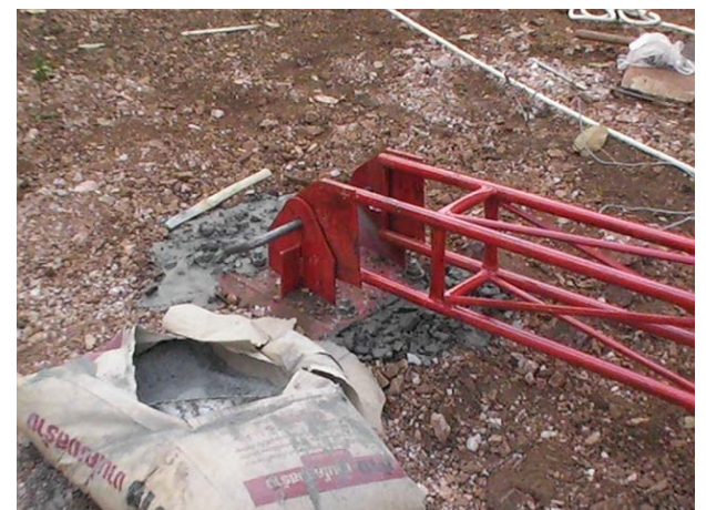
รูปที่ 162 ประกอบเสา กับฐานเสาที่ออกแบบให้มี จุดหมุนเพื่อสะดวกต่อการติดตั้ง
