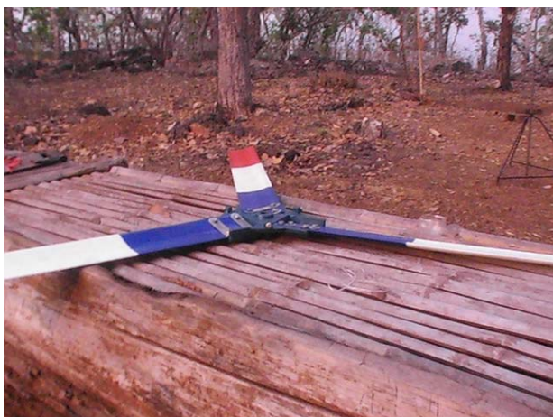
รูปที่ 163 ประกอบใบกังหันลมเพื่อติดตั้งเข้ากับ เจนเนอเรเตอร์ของกังหัน
