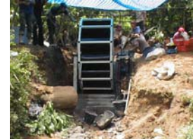
รูปที่ 34 นักวิจัย และผู้ช่วยนักวิจัยและชาวบ้าน ประกอบ Bucket เข้ากับโครงวงล้อน้ำ และทาสี
