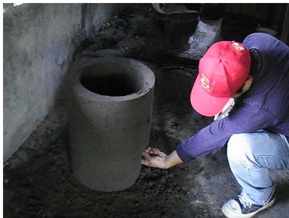
รูปที่ 182 ค่อยๆ ถอดแม่แบบทำเตาออก จะได้ลำตัวเตา
