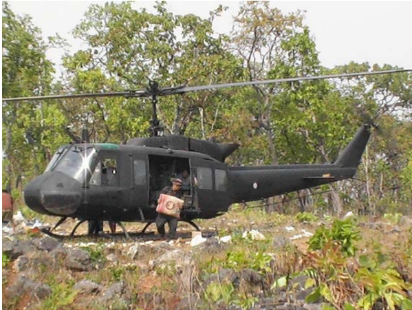
รูปที่ 157 เฮลิคอปเตอร์ขนส่งปูนซีเมนต์ และถุงทราย ที่จำเป็นสำหรับเสาเข็มกั้นดิน ในเที่ยวที่สาม
