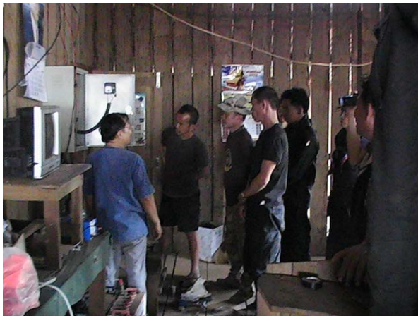
รูปที่ 171 อาจารย์หิณ ชนสุด แนะนำการใช้งานตู้ควบคุมการจ่ายพลังงานไฟฟ้าจากพลังงานลม
