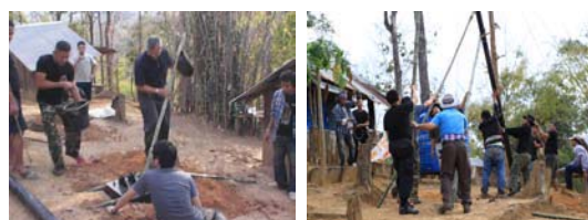
รูปที่ 22 นักวิจัยและเจ้าหน้าที่ทหารพรานฐาน BP 14 ช่วยกัน ติดตั้งกังหันลม ขนาด 200 W 24 V.DC ความสูงเสากังหัน 12 เมตร
