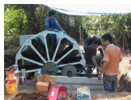
รูปที่ 34 นักวิจัย และผู้ช่วยนักวิจัยและชาวบ้าน ประกอบ Bucket เข้ากับโครงวงล้อน้ำ และทาสี
