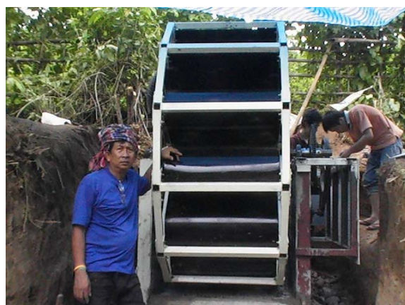
รูปที่ 224 โครงวงล้อน้ำที่ประกอบ Bucket เรียบร้อยแล้ว
