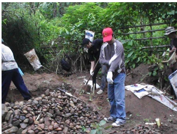
รูปที่ 203 ทีมวิจัยกำหนดจุด รูปแบบและขนาดของหลุมที่จะวางฐานวงลื่อน้ำให้ทีมชาวบ้านขุด
