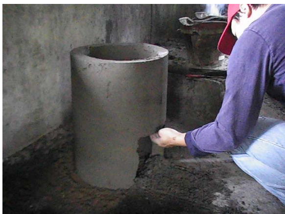
รูปที่ 183 เจาะประตูเตาขณะลำตัวเตายังไม่แข็งมากนักสำหรับเป็นช่องใส่ฟืนและอากาศไหลเข้า
