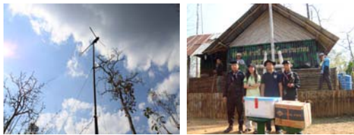
รูปที่ 23 กังหันลม ขนาด 200 W 24 V.DC ความสูงเสา กังหัน 12 เมตร ติดตั้งเรียบร้อย นักวิจัยได้ทำพิธีมอบ ให้กับ ทหารพรานฐาน BP 14
