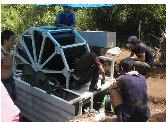
รูปที่ 221 ติดตั้งBucket กับ โครงวงล้อน้ำ
