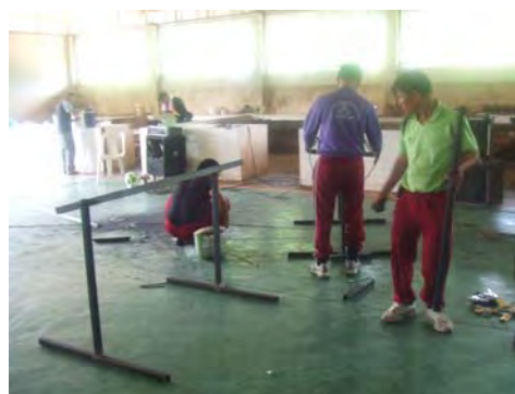
โครงสร้างแผงรับโซลาเซลล์ ที่กำลังพล จัดทำไปติดตั้ง ณ ฐานปฏิบัติการ
