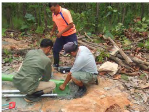
กำลังพล นำอุปกรณ์เสาโซลาเซลล์ติดตั้งกับฐานเสา
