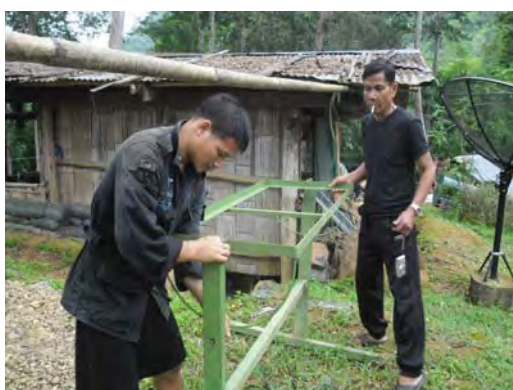
กำลังพล นก.ทพ. 36 ประกอบติดตั้งโครง รองรับแผงโซลาเซลล์กับแผ่นโซลาเซลล์ฐาน
