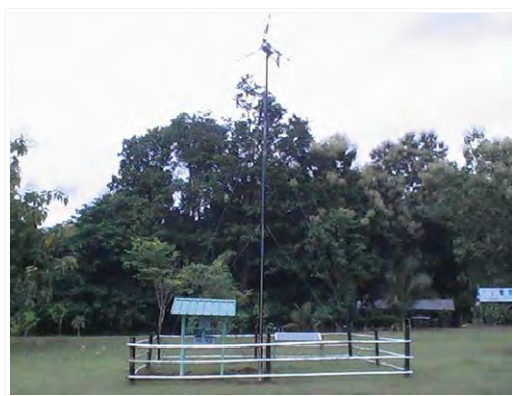
รูปกังหันลม และ โซลาเซลล์แบบ ผสมผสาน ณ ศูนย์การเรียนรู้พลังงาน ทดแทน จก.ทพ.36
