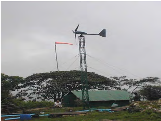
กำลังพล จก.ร.7 ติดตั้งกังหันลมแนวนอน ณ ฐานปฏิบัติการคอยต๋อหม้อก สูงจาก ระดับน้ำทะเล 1650 เมตร
