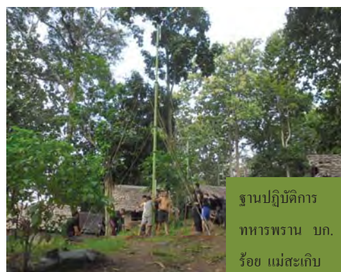
กำลังพล จก.ทพ. 36 ติดตั้งกังหันลม แนวนอน ณ ฐานปฏิบัติการแม่สะเก็บ
