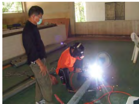
กำลังพล ทำการเชื่อมประกอบโครงสร้าง เสา กังหันลมและโซลาเซลล์
