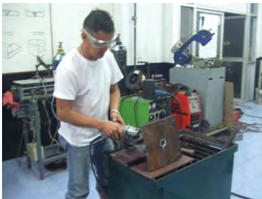
ปฏิบัติการประกอบฐานบนของเสากังหันลม แนวตั้ง
