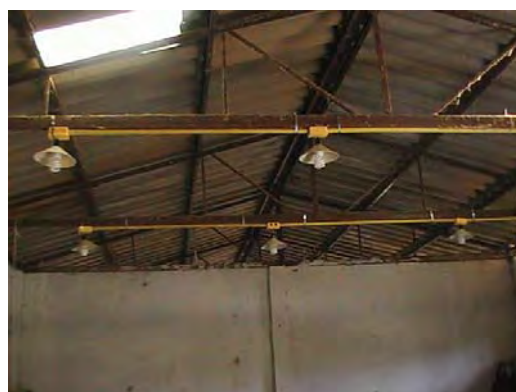
กำลังพลนำความรู้ที่ได้รับการอบรม เดินไฟ และติดตั้งโคมไฟแสงสว่างภายในอาคารที่
