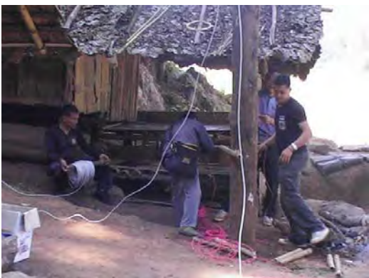
กำลังพล เดินสายไฟจากกังหันน้ำ เข้าใช้งานภายในฐานปฏิบัติการแม่ตี
