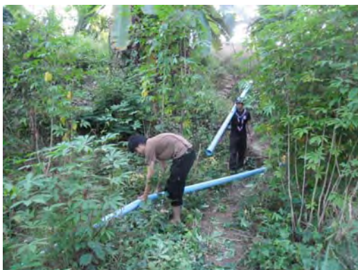
แนวท่อส่ง น้ำถูกเดินท่อส่งเข้าถึงโรงกักกั้นน้ำ
