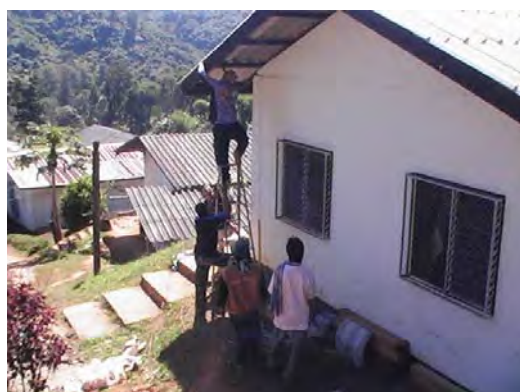
กำลังพล จก.ทพ. 36 เดินสายส่ง จ่ายไฟฟ้า เข้าอาคารที่พัก เด็กนักเรียน
