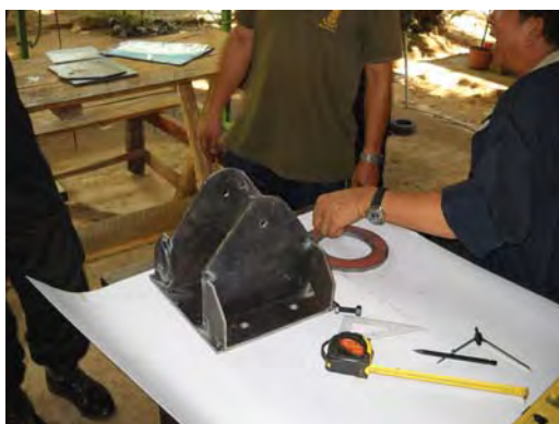
ชิ้นส่วนฐานกึ่งหันลมถูกเชื่อมประกอบยึด ติดกัน
