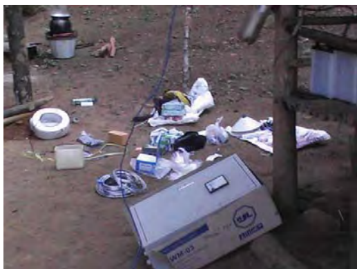
กำลังพล เตรียมติดตั้งชุดควบคุมไฟจากกังหันน้ำ เข้าใช้งานภายในฐานปฏิบัติการแม่ตี
