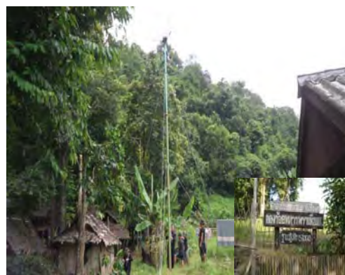
กำลังพล จก.ทพ. 36 ติดตั้งกังหันลม แนวนอน ณ ฐานปฏิบัติการสบเมบ
