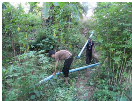
วางแนวท่อส่ง น้ำ เพื่อส่งเข้าโรงกักเก็บน้ำ ผ่านแนวป่า
