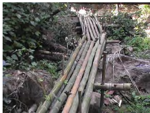
กำลังพลเตรียมจัดการสร้างโครงรองรับราง ส่งน้ำ เข้ากังหันน้ำ ณ ฐานปฏิบัติการแม่ติ
