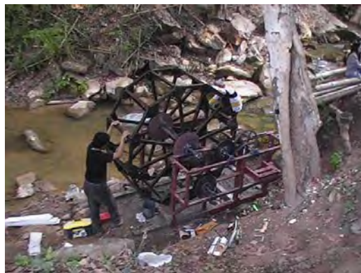
กังหันน้ำชนิดลื่อน้ำที่ถูกออกแบบถอดประกอบได้ ถูกนำมาติดตั้ง ณ ฐานปฏิบัติการ
