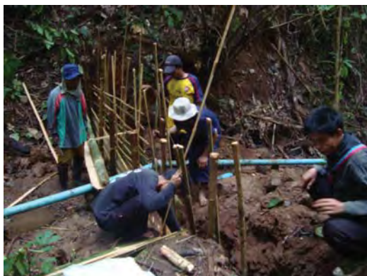
กำลังพลทหารพรานฉก.ทพ. 36 จัดเตรียม ฝายชะลอน้ำ กิ่งถาวรเพื่อเป็นน้ำต้นทุนในลำ ห้วยหลังโรงเรียนล่องแพวิทยา หมู่บ้านสบ
