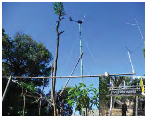
กำลังพล จก.ทพ. 36 ติดตั้งกังหันลม แนวนอน ณ ฐานปฏิบัติการชอแง สูงจาก ระดับน้ำทะเล 1250 เมตร
