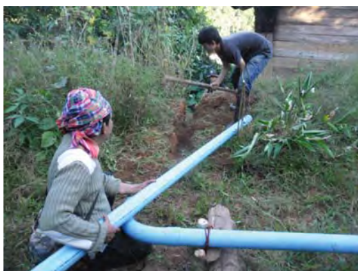
กำลังพลทหารพรานฉก.ทพ.36 วางแนวท่อ ส่ง น้ำ เพื่อส่งเข้าโรงกักเก็บน้ำ
