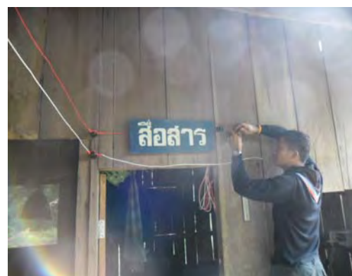
เดินระบบไฟฟ้าจากพลังงานทดแทน เพื่อ สำรองพลังงานไฟฟ้าให้กับอุปกรณ์สื่อสาร
