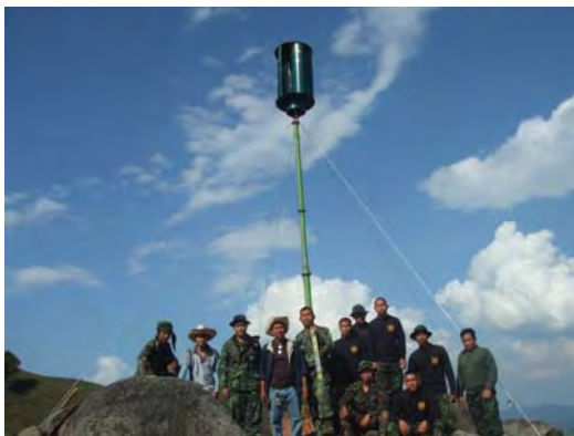
กำลังพล จก.ร.7 ติดตั้งกังหันลมแนวนอน ณ ฐานปฏิบัติการคอยหัวม้า สูงจากระดับน้ำทะเล 1650 เมตร
