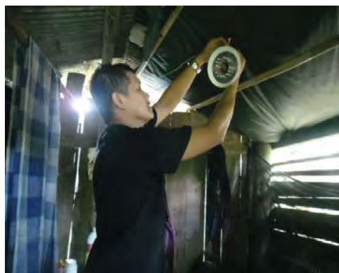
กำลังพลที่ผ่านการอบรมนำความรู้ที่ได้จาก การฝึกนำไปปฏิบัติติดตั้งไฟแสงสว่าง ภายในเบมท์ที่พักฐานปฏิบัติการ
