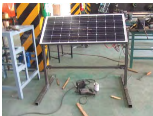
ทดสอบประกอบโครงรองรับแผงโซลาเซลล์
