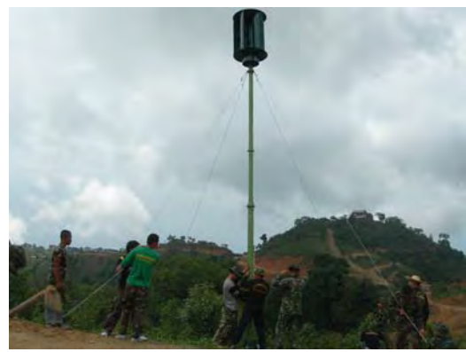
กำลังพล จก.ร.7 ติดตั้งกังหันลมแนวนอน ณ ฐานปฏิบัติการไตแลง
