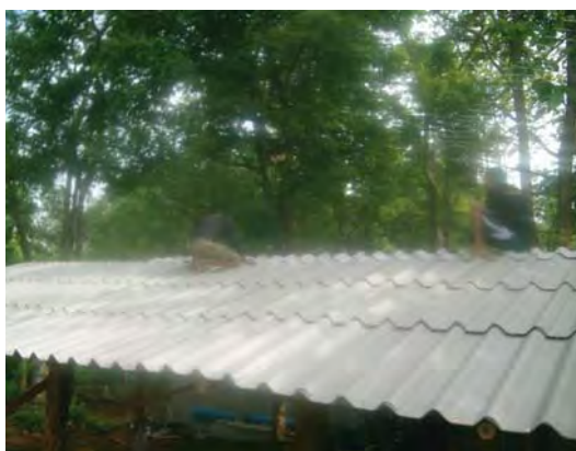
กำลังพลหน่วยเฉพาะกิจกรรมทหารพรานที่ 36 ติดตั้งโครงหลังคาศูนย์การเรียนรู้
