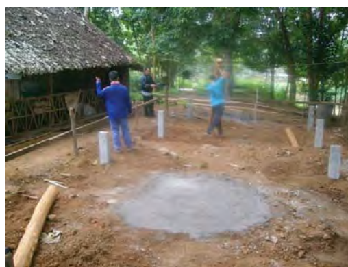
กำลังพลหน่วยเฉพาะกิจกรรมทหารพรานที่ 36 วางผังติดตั้งเสาอาคาร
