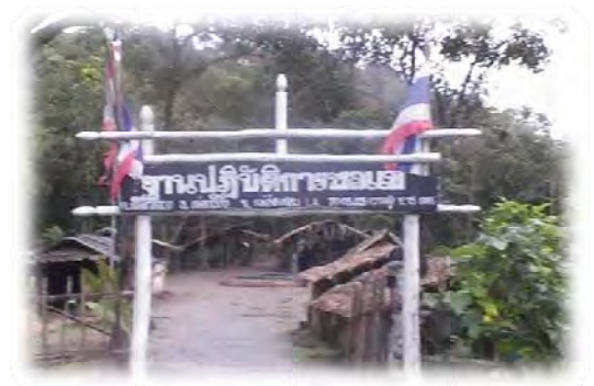
รูปที่ 8 ฐานปฏิบัติการ ชอ.แจ้ ตั้งอยู่บนยอดเขาแนวตะเข็บชายแดนไทยพม่า อากาศจะปิดบ่อย มีกระแสลมพัดเข้าหาฐาน
