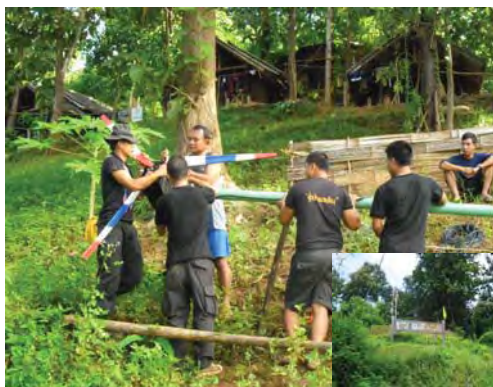
กำลังพล จก.ทพ. 36 ติดตั้งกังหันลมแนวนอน ณ ฐานปฏิบัติการบ้านแม่สามแลบ
