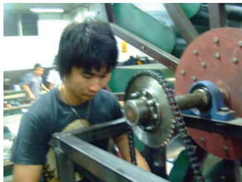
ฝึกการประกอบระบบส่งกำลัง กังหันน้ำ ผลิตไฟฟ้าชนิดล้อย่น้ำ
