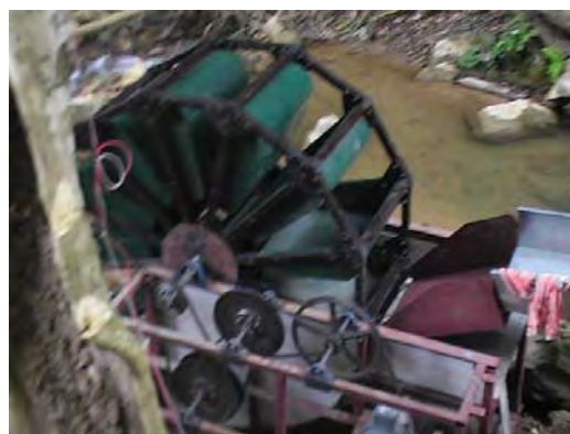
กังหันน้ำชนิดลื่อน้ำที่ถูกออกแบบถอดประกอบได้ ถูกนำมาติดตั้ง ณ ฐานปฏิบัติการแม่ตี โดยกำลังพล เสร็จเรียบร้อย
