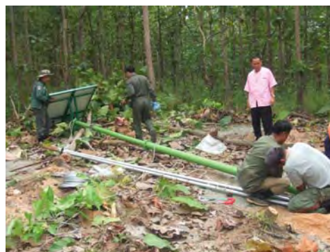
กำลังพล นำอุปกรณ์ แผงโซลาเซลล์ติดตั้งกับ เสาเพื่อเตรียมยกติดตั้งตามตำแหน่ง
