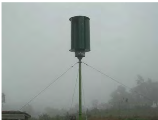
กำลังพล จก.ร.7 ติดตั้งกังหันลมแนวนอน ณ ฐานปฏิบัติการป่าไม้
