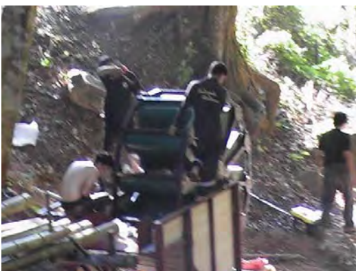
กำลังพล สามารถนำความรู้จากการฝึกทำการติดตั้ง กังหันน้ำชนิดลื่อน้ำที่ถูกออกแบบถอดประกอบได้ ถูกนำมาติดตั้ง ณ ฐานปฏิบัติการแม่ตี
