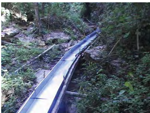
กำลังพลติดตั้งรางรับน้ำให้ไหลลงกังหันน้ำ ณ ฐานปฏิบัติการแม่ตี
