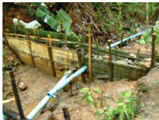
ฝายชะลอน้ำกิ่งถาวรที่สร้างเสร็จเพื่อเป็นน้ำ ต้นทุนในลำห้วยหลังโรงเรียนล่องแพวิทยา หมู่บ้านสบโขง
