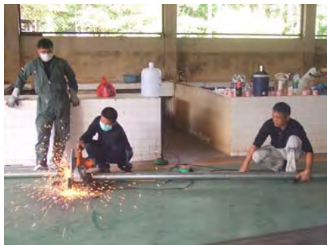
กำลังพล ทำการสร้างประกอบโครงสร้าง เสา ระบบกังหันลมและโซลาเซลล์
