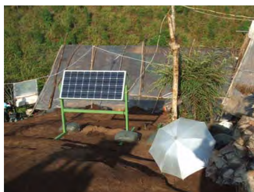
กำลังพล นก.ทพ. 36 ประกอบติดตั้งโครง รองรับแผงโซลาเซลล์กับแผ่นโซลาเซลล์ฐาน ปฏิบัติการคอยหัวม้า
