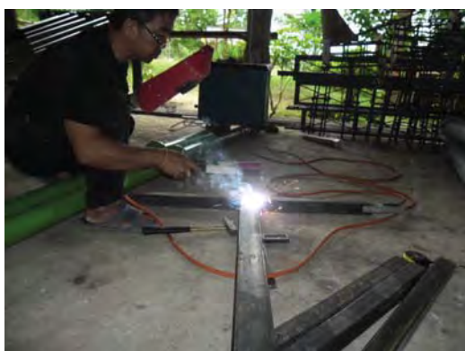
กำลังพล นก.ทพ.36 และนก.ร .7 ฝึกปฏิบัติ เชื่อมโครงรองรับแผงโซลาเซลล์
