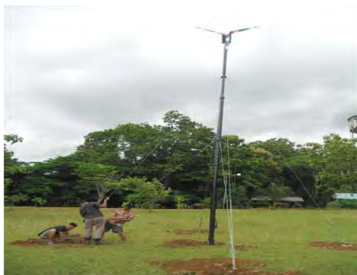
รูปกำลังพลฝึก การจำลองการติดตั้ง กังหันลม และ โซลาเซลล์แบบผสมผสาน
