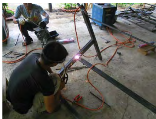
กำลังพล นก.ทพ.36 และนก.ร .7 ฝึกปฏิบัติ ประกอบโครงรองรับแผงโซลาเซลล์
