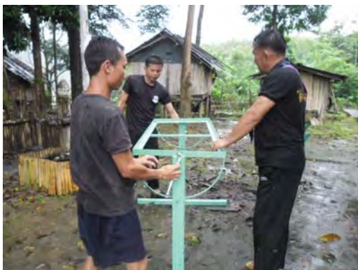
รูปกำลังพล นก.ทพ. 36 ประกอบติดตั้ง โครงรองรับแผงโซลาเซลล์กับแผ่นโซลา เซลล์ ที่ฐานปฏิบัติการสบขวม
