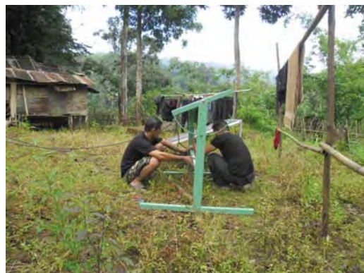
รูปกำลังพล นก.ทพ. 36 ประกอบติดตั้ง โครงรองรับแผงโซลาเซลล์กับแผ่นโซลา เซลล์ ที่ฐานปฏิบัติการสบเมย
