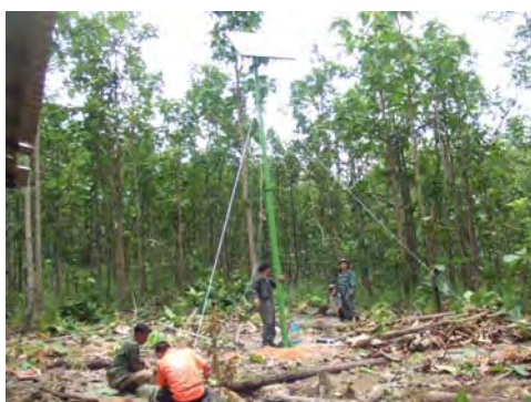
กำลังพล ยก ติดตั้งเสาโซลาเซลล์ วัดระดับทางตั้ง และ ยึดสายสลิง
