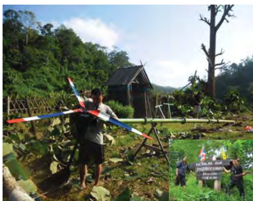
กำลังพล จก.ทพ. 36 ติดตั้งกังหันลมแนวนอน ณ ฐานปฏิบัติการอูเลาะ
