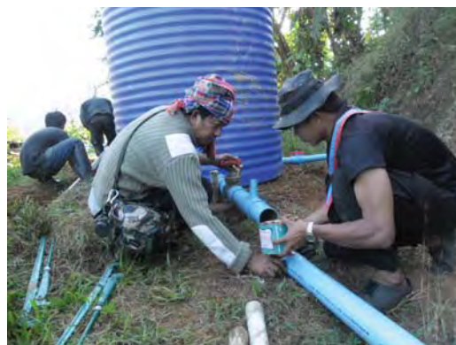
กำลังพลทหารพรานฉก.ทพ.36 ต่อระบบท่อส่ง น้ำจากถังพักเพื่อส่งเข้าโรงกักเก็บน้ำ ด้านล่าง
