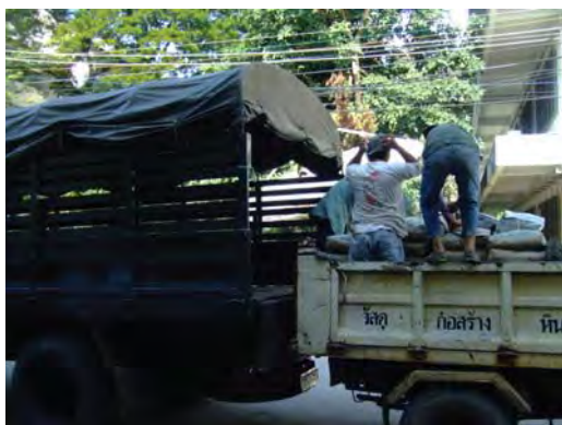
กำลังพลหน่วยเฉพาะกิจกรรมทหารพราน ที่36 ร่วมขนวัสดุอุปกรณ์ก่อสร้าง
