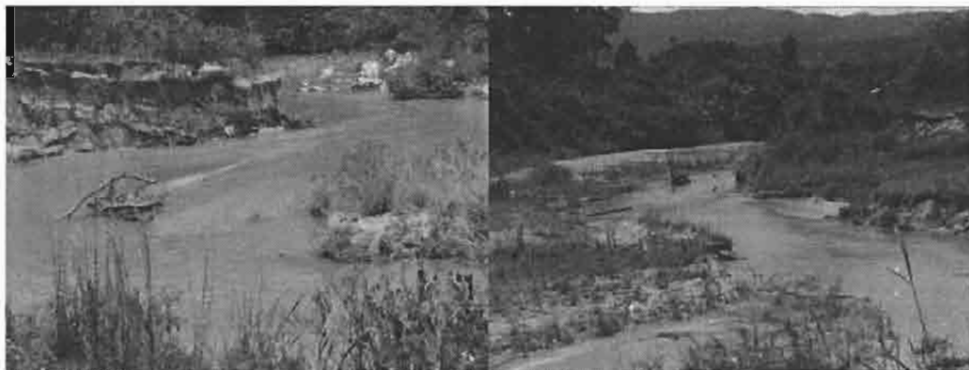
ดลิงพังและสภาพน้ำในคลองรัตนภูมิดินเขิน
