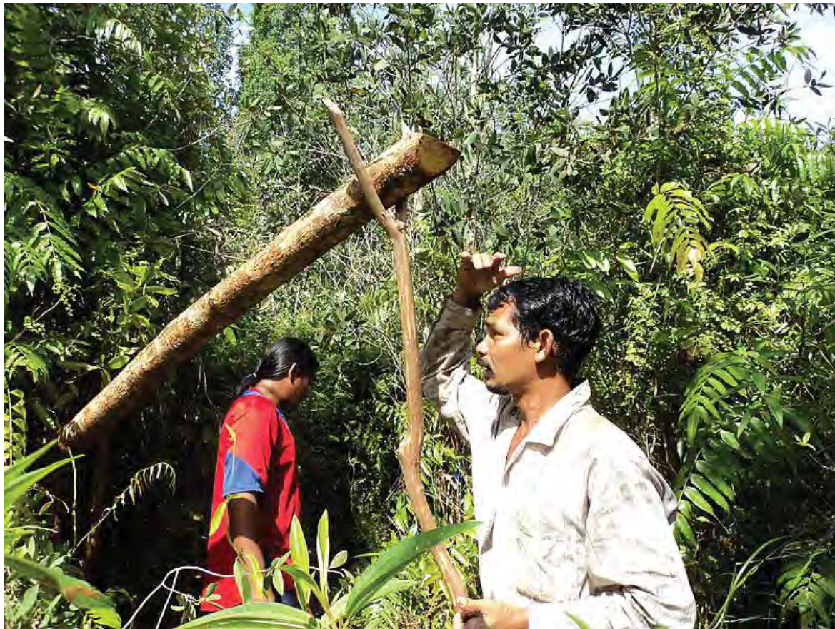
การวางไม้พาดระยะห่างเสาหน้าและเสาหลัง 2-3 เมตร ตามความยาวของไม้พาด
