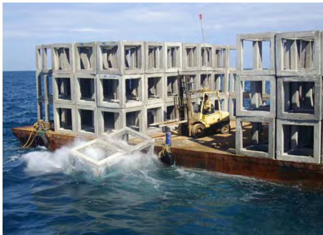
ภาพที่ 2: ปะการังเทียมแบบแท่งคอนกรีต
