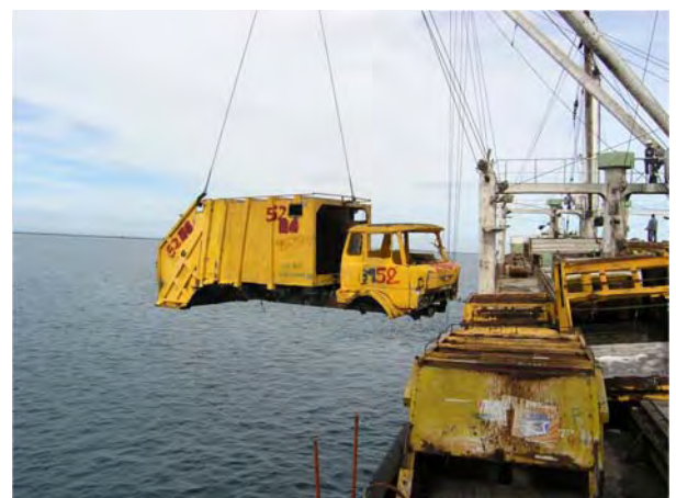
ภาพที่ 4: ปะการังเทียมแบบรถยนต์/รถถัง
