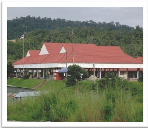
ภาพที่ 4 อาคารที่จำหน่าย สินค้าด่านภูมู่
