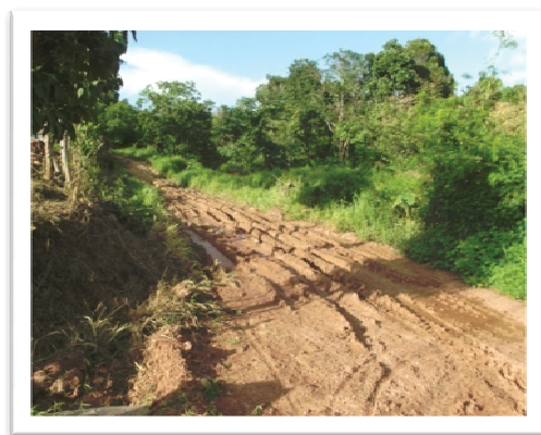
ภาพที่ 16 สภาพถนนทางเข้าไปยังด่านภูดู่ที่ขึ้น ดินโคลนในฤดูฝน
