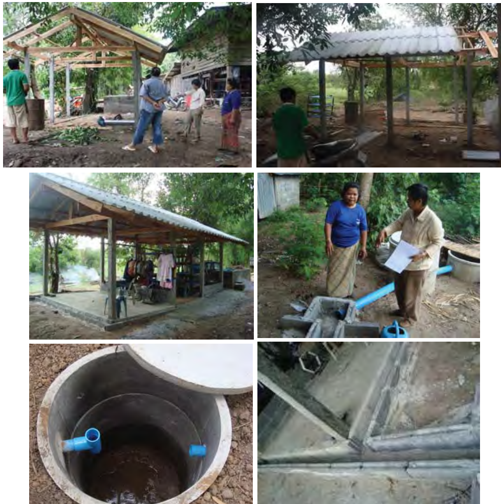
ภาพที่ 6. การก่อสร้างโรงเรือนการผลิตไหมฉีร์ที่เป็นมิตรกับสิ่งแวดล้อมที่บ้านคุณทองสูงน สมคำภี และการปรับปรุงบ่อบำบัดน้ำเสีย และวางน้ำรอบโรงเรือน
