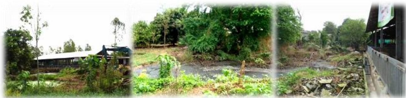
ภาพที่ 4.1 สภาพของเสียและน้ำเสียของฟาร์มก่อนดำเนินการติดตั้งระบบบำบัดน้ำเสียชีวภาพ
