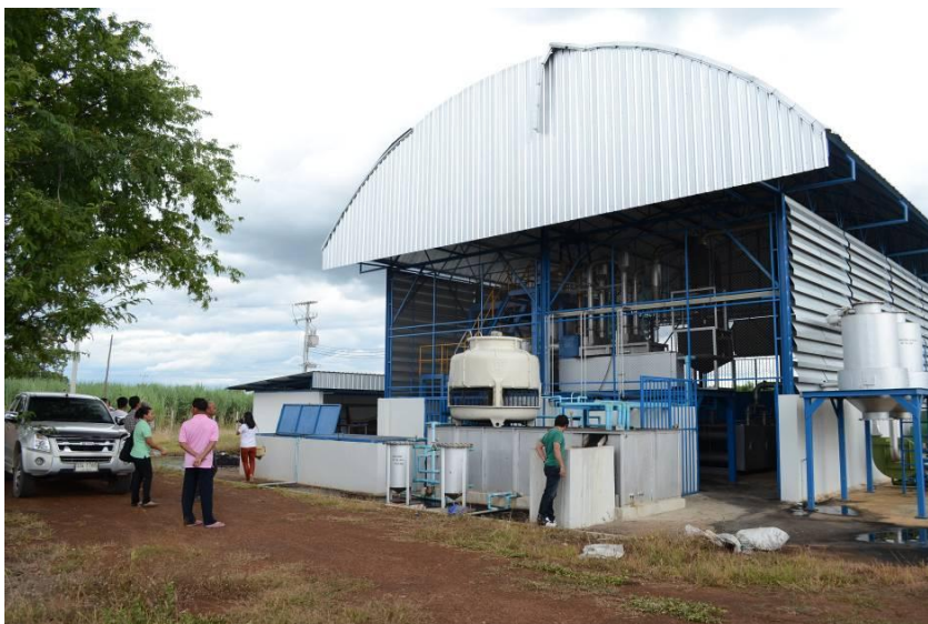
ภาพที่ 3.11 โรงไฟฟ้าจากชีวมวล
