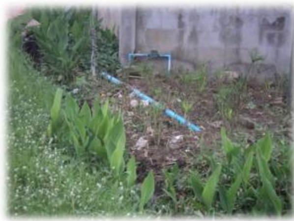
ภาพที่ 4.9 ตัวอย่างบริเวณที่เกิดการแตกรั่วของท่อจ่ายก๊าซชีวภาพ
