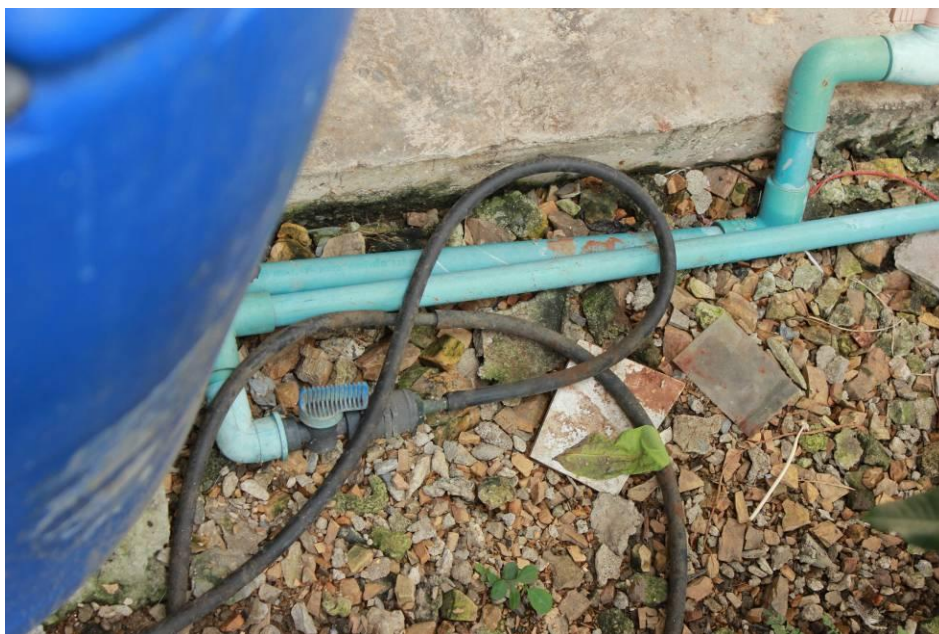
ภาพที่ 3.24 ท่อก๊าซที่ต่อก๊าซชีวภาพจากบ่อหมักมาสู่แต่ละครัวเรือน
