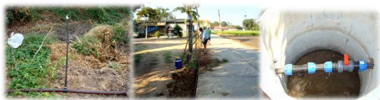
ภาพที่ 4.3 ระบบท่อจ่ายน้ำชีวภาพของชุมชน
