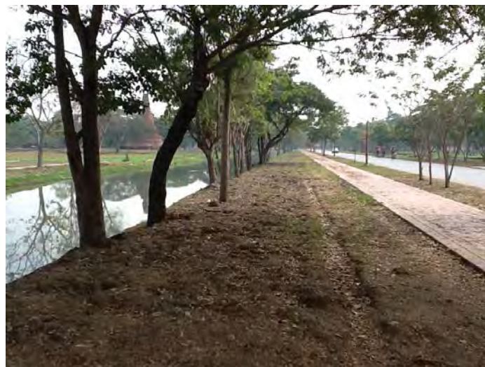
ภาพที่ 2.50 ภาพถนนเหล็กหลังการบูรณะ
