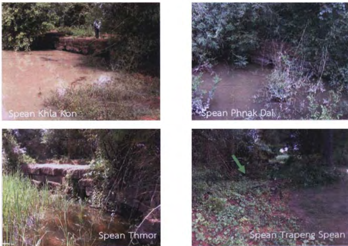
ภาพที่ 3.32 ภาพการสำรวจสะพานศิลาแลง
