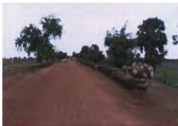
ภาพที่ 5.2 ลักษณะของถนนบนแนวสะพานโบราณในปัจจุบัน
