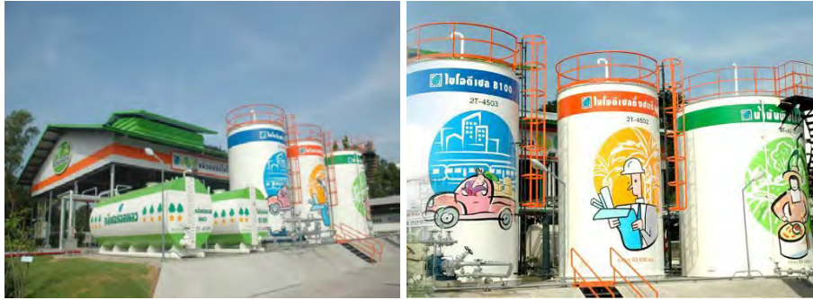
หน่วยผลิตไบโอดีเซลขนาด 20,000 ลิตรต่อวัน องค์กรความรู้จากโครงการสวนพระองค์ สวนจิตรลดา
