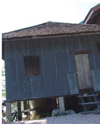
รูป 4-25 ลักษณะบ้านยกพื้นใต้ถุนสูง
