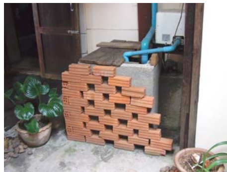
รูป 4-19 การสร้างบ่อเก็บน้ำฝนบ่อน้ำไว้ใต้พื้นบ้าน
