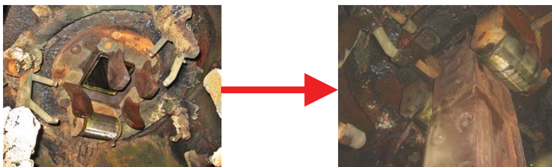
รูปที่ 35 การปรับปรุงแก้ไข Guide ใต้ Mould
