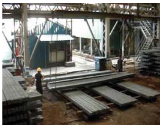
รูปที่ 21 Cooling Bed และ Billet Yard
