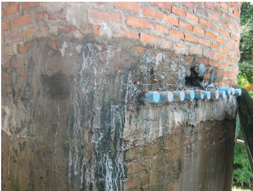
รูปที่ 3.19 การอุดรูรั่วภายในด้วย water plug cement
