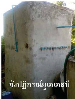
รูปที่ 3.12 ระบบบำบัดน้ำเสียเมื่อก่อสร้างและปรับสภาพบ่อแล้วเสร็จ
