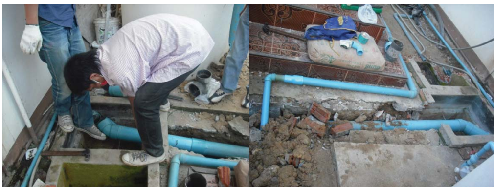
รูปที่ 3.11 ท่อระบายน้ำเสียชั่วคราว
