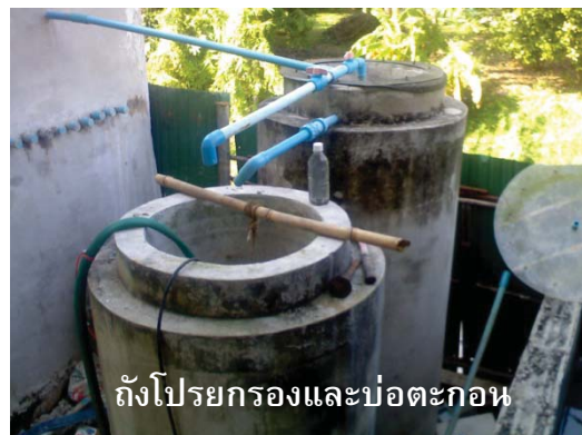
รูปที่ 3.12 ระบบบำบัดน้ำเสียเมื่อก่อสร้างและปรับสภาพบ่อแล้วเสร็จ
