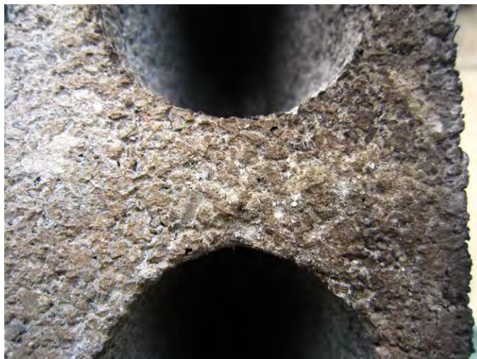
รูปที่ 24 ลักษณะเนื้อของคอนกรีตบล็อกเศษพลาสติกอีวีเอฟสมยางวัลคาไนซ์ภายหลังทดสอบการลามไฟและลุกติดไฟ
