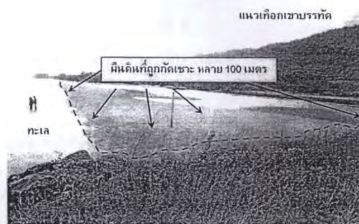
ภาพที่ 4.36 แนวการกัดเซาะที่รุนแรงจากการถมเขื่อนหินของเอกชน
