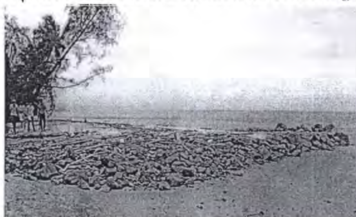
ภาพที่4.35 การถมหินเป็นแนวกันคลื่นเซาะฝั่ง
