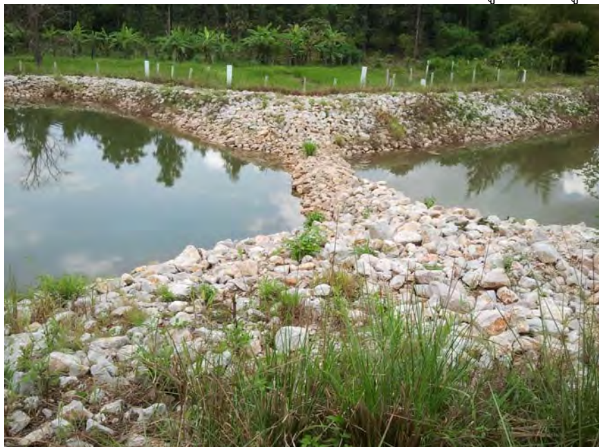
ภาพบ่อพักน้ำเพื่อให้น้ำตกตะกอนก่อนการผลิตน้ำประปาของหมู่ ๑ และหมู่ ๘
