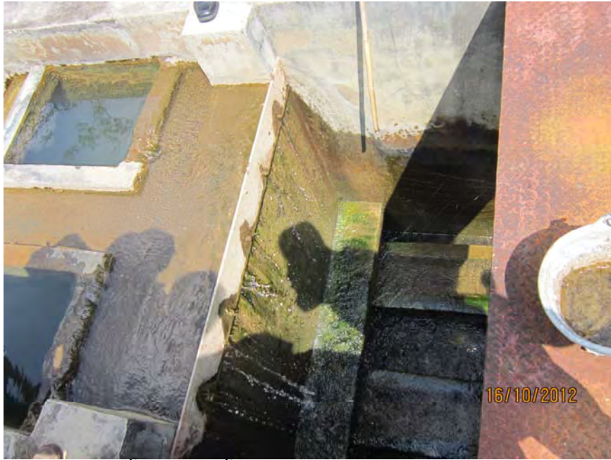
ภาพตะไคร้ที่ปนเปื้อนกับน้ำที่ผ่านการกรองทรายในระบบประปาหมู่บ้าน
