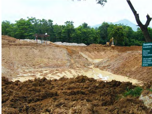
ภาพการก่อสร้างอ่างเก็บน้ำเพื่อพักน้ำก่อนการผลิตน้ำประปา
