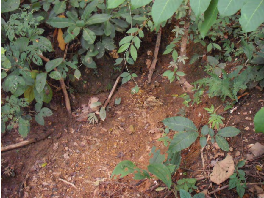
รูปที่ ข.141 รูปก่อนทำฝายที่ 71
