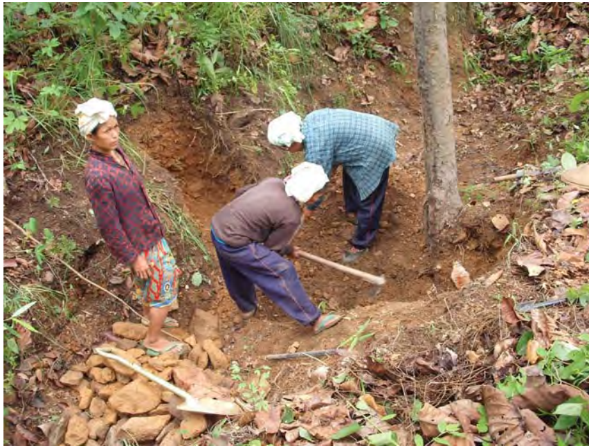
รูปที่ ก.5 เตรียมพื้นที่สร้างฝาย
