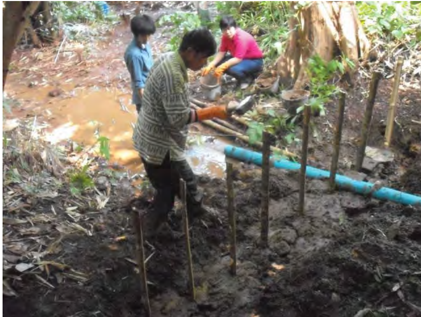
รูปที่ 3.7 เทดินซีเมนต์ลงในฐานและตอกหลักไม้ไผ่เป็นแกนกลาง
