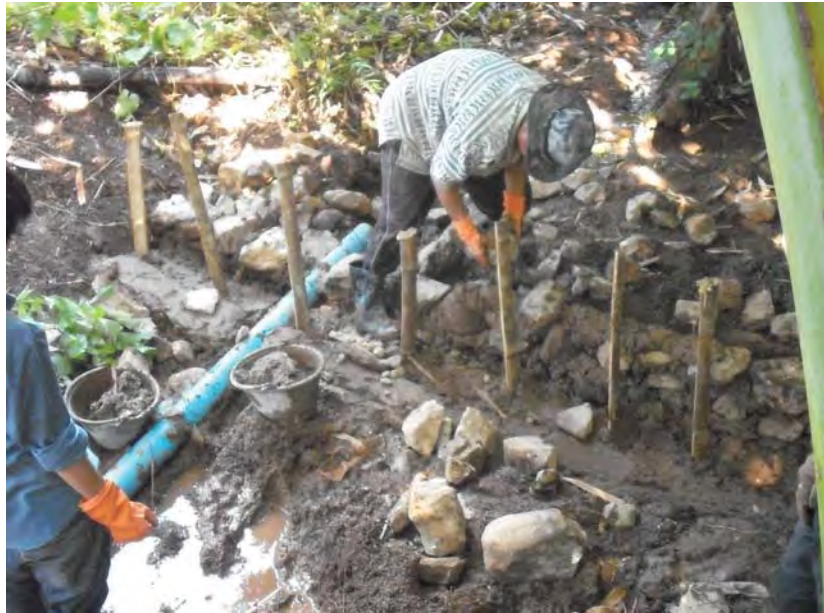
รูปที่ 3.9 ก่อหินด้านหน้าและด้านหลังฝายตลอดความกว้างของลำห้วย
