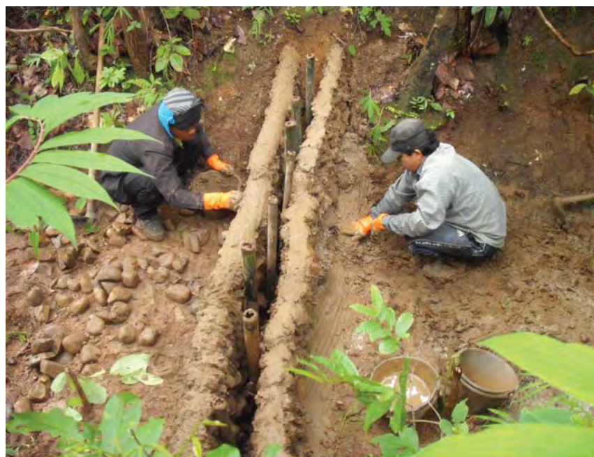
รูปที่ ก.8 ก่อสร้างฝาย
