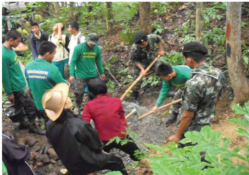
รูปที่ ก.4 เตรียมวัสดุสร้างฝาย
