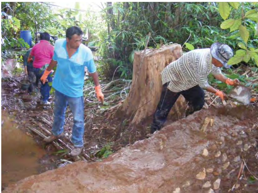
รูปที่ 3.10 ถมดินเป็นแกนกลางให้เต็มและเทพูนผสมดินทับสันฝายให้เต็ม
