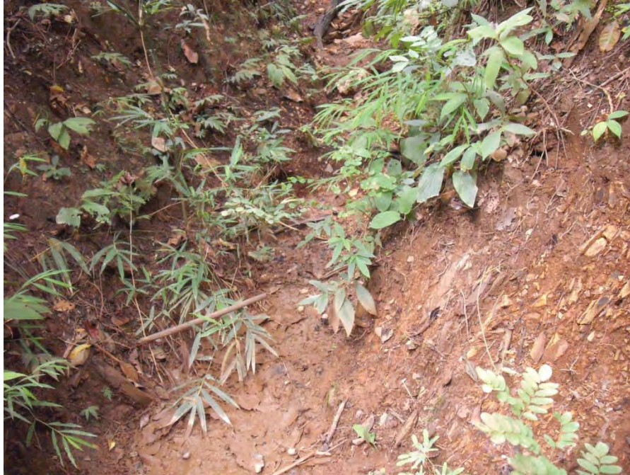
รูปที่ ข.135 รูปก่อนทำฝายที่ 68
