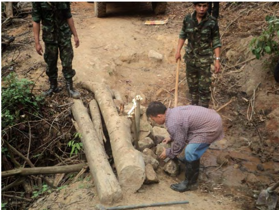
การก่อสร้างฝายบริเวณพื้นที่เชิงเขาดันน้ำปาย
