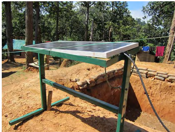
ติดตั้งโซล่าเซลล์ฐานปฏิบัติการชายแดน เนิน 585
