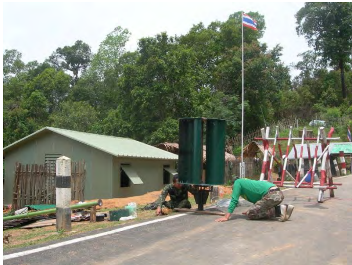
กำลังพลเตรียมติดตั้งกั้นหลมแนวตั้ง ณ ฐานปฏิบัติการช่องทางนาป่าแปก
