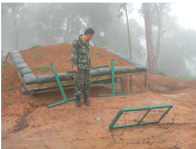
การติดตั้งส่วนประกอบโครงรับโซลาร์เซลล์ ณ ฐานปฏิบัติการป่าไม้
