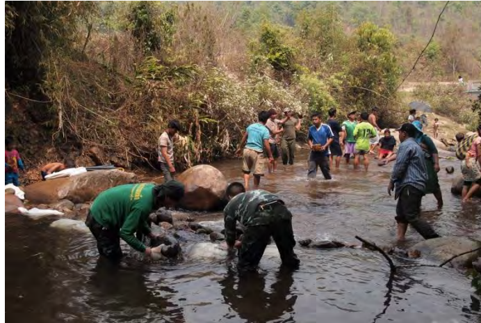
ชาวบ้านและกำลังพล ขนกระสอบทราย จัดสร้างฝายชลและยกระดับน้ำเข้าขับเคลื่อนกังหันปั้มน้ำชนิดล้อยน้ำ
