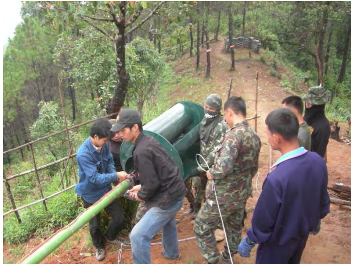
กำลังพ่นน้ำกั้นหลุมขึ้นติดตั้ง ณ ฐานปฏิบัติการ หอดูไฟ
