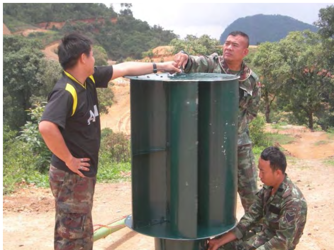
กำลังพลติดตั้งส่วนลำตัวกังหันลมแนวตั้งเพื่อผลิตไฟฟ้าสำรองใช้ในฐานปฏิบัติการไตแลง
