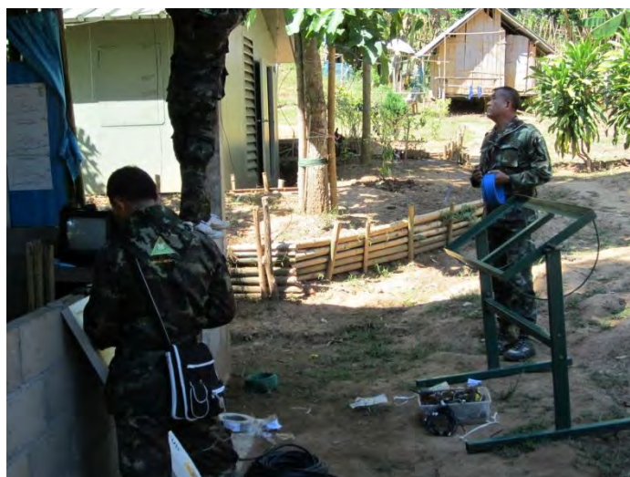
ติดตั้งแผงโซล่าเซลล์ฐานปฏิบัติการน้ำเพียงดิน
