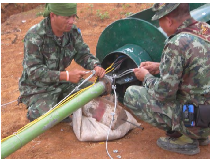
การติดตั้งส่วนประกอบยึดเสากังหันลมแนวตั้ง ณ ฐานปฏิบัติการป่าไม้
