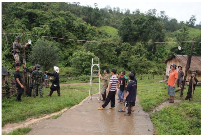
การมีส่วนร่วมของชาวบ้านติดตั้งระบบไฟแสงสว่าง บ้านหัวปาย
