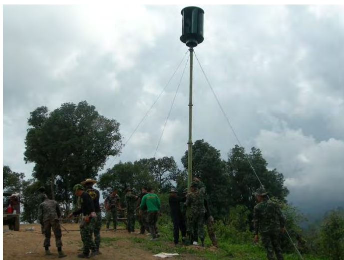
กำลังพลทำการติดตั้งกังหันลมผลิตไฟฟ้า ณฐานปฏิบัติการไตแลง
