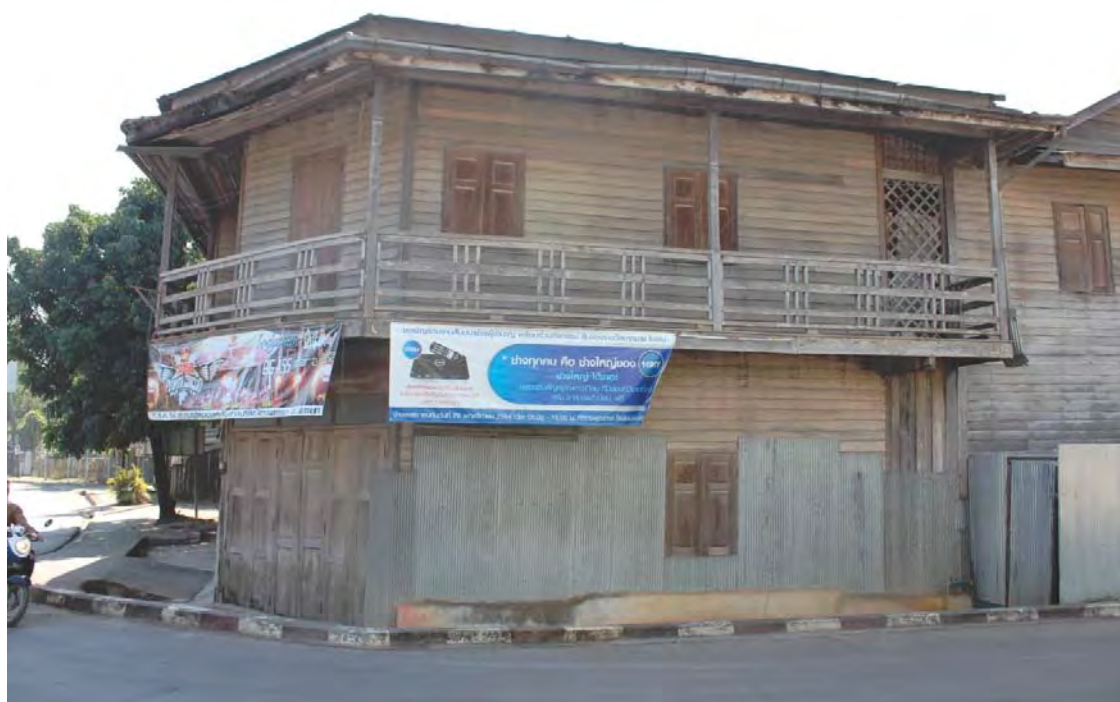
ภาพที่ 3.1.32: แสดงภาพอาคาร กลุ่มอาคาร F อาคารร้างบริเวณมุมถนน ที่มา : จากการเก็บข้อมูล วันที่ 20 มกราคม 2555
