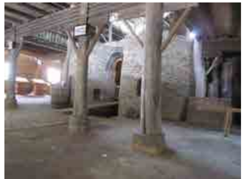
ภาพที่ 5.14 : อาคารเตาอนุรักษ์ แบบเตาเผาทรงหมั่นโถวในสมัยราชวงศ์หยวน (元代馒头窑) อาคารโครงสร้างไม้ชั้นเดียวทรงสูงครอบเตาเผาไว้ ส่วนบริเวณว่างในพื้นที่อาคารเรือนเตาทั้งหมดใช้เป็นพื้นที่เก็บฟืน หีบหนไฟ พื้นที่เตรียมชิ้นงานเพื่อเข้าเตาและยังเป็นส่วนสำหรับคนงานพักอาศัยเพื่อควบคุมเตา
