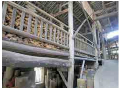
ภาพที่ 5.15 : อาคารเตาอนุรักษ์ แบบเตาเผาทรงน้ำเต้าในสมัยราชวงศ์หมิง (明代葫芦窑) อาคารโครงสร้างไม้สองชั้นทรงสูงครอบเตาเผาไว้ ส่วนบริเวณว่างชั้นบนรอบอาคารเตาทั้งหมดใช้เป็นพื้นที่เก็บฟืน เตาทรงน้ำเต้านี้เป็นช่วงพัฒนาจากเตามังกรก่อนจะเป็นเต้าเจิ้น ที่เป็นเตาฟืนที่ให้คุณภาพของการเผาดีที่สุด ส่วนบนข้างหลังคาเตา คนคุมเตาสามารถเดินขึ้นมาเพื่อเสียบฟืนและสังเกตไฟได้
