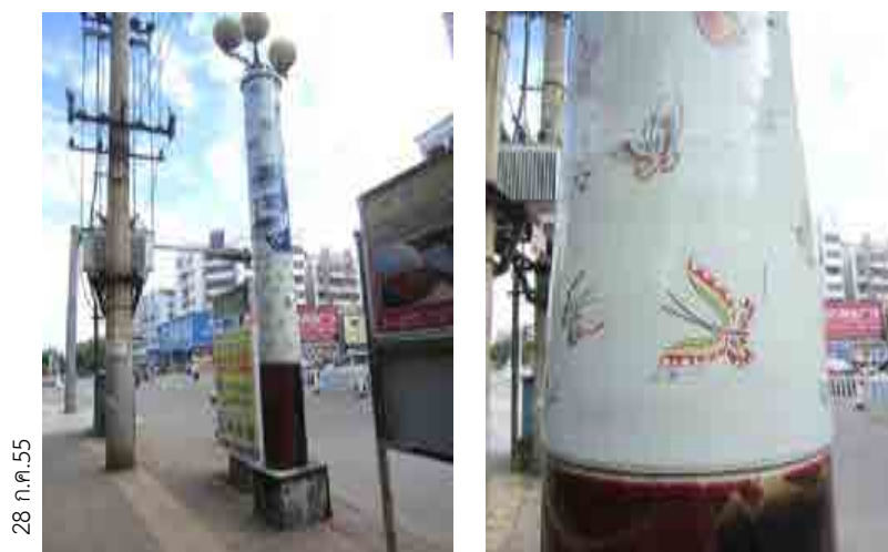
ภาพที่ 5.46 : ปelokกระเบื้องหุ้มเสาไฟฟ้าทั้งเมืองจิ่งเต๋อเจิ้น ที่มีการออกแบบลักษณะและลวดลายตกแต่งหลากหลาย โดยได้รับความร่วมมือจากภาคเอกชนร่วมผลิตปelokกระเบื้องนี้ นอกจากความสวยงามแล้วยังเป็นฉนวนไฟฟ้าและกันงูเลื้อยขึ้นเสาไฟฟ้าได้ดี มีความคงทนสูงเพราะเป็นเนื้อระดับ hi-porcelain
