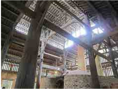
ภาพที่ 5.14 : อาคารเตาอนุรักษ์ แบบเตาเผาทรงหมั่นโถวในสมัยราชวงศ์หยวน (元代馒头窑) อาคารโครงสร้างไม้ชั้นเดียวทรงสูงครอบเตาเผาไว้ ส่วนบริเวณว่างในพื้นที่อาคารเรือนเตาทั้งหมดใช้เป็นพื้นที่เก็บฟืน หีบหนไฟ พื้นที่เตรียมชิ้นงานเพื่อเข้าเตาและยังเป็นส่วนสำหรับคนงานพักอาศัยเพื่อควบคุมเตา
