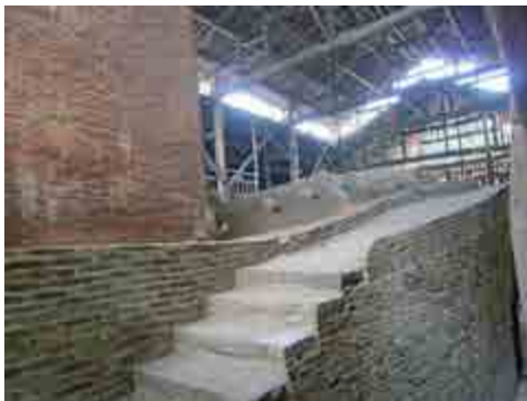
ภาพที่ 5.14 : อาคารเตาอนุรักษ์ แบบเตาเผาทรงหมั่นโถวในสมัยราชวงศ์หยวน (元代馒头窑) อาคารโครงสร้างไม้ชั้นเดียวทรงสูงครอบเตาเผาไว้ ส่วนบริเวณว่างในพื้นที่อาคารเรือนเตาทั้งหมดใช้เป็นพื้นที่เก็บฟืน หีบหนไฟ พื้นที่เตรียมชิ้นงานเพื่อเข้าเตาและยังเป็นส่วนสำหรับคนงานพักอาศัยเพื่อควบคุมเตา
