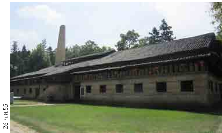
ภาพที่ 4.11 : เตาเผาจิ้นจะอยู่ภายในเรือนเตา เตาเผาแบบประเพณีของจีนชนิดแบบที่มีปล่องเตาจะอยู่ในเรือนเตาทั้งสิ้น ซึ่งจะแตกต่างจากเตามังกรที่ใช้ทำเลภูมิศาสตร์ในการก่อเป็นเตาเผา
