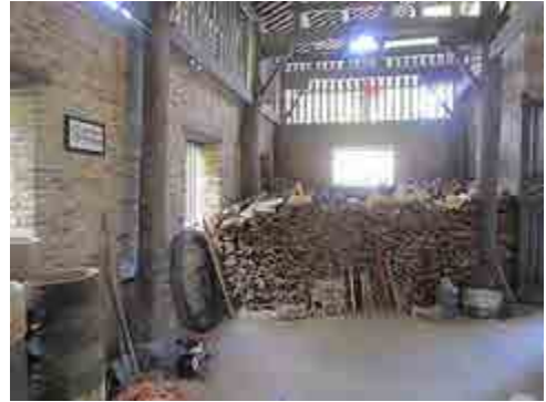
ภาพที่ 5.14 : อาคารเตาอนุรักษ์ แบบเตาเผาทรงหมั่นโถวในสมัยราชวงศ์หยวน (元代馒头窑) อาคารโครงสร้างไม้ชั้นเดียวทรงสูงครอบเตาเผาไว้ ส่วนบริเวณว่างในพื้นที่อาคารเรือนเตาทั้งหมดใช้เป็นพื้นที่เก็บฟืน หีบหนไฟ พื้นที่เตรียมชิ้นงานเพื่อเข้าเตาและยังเป็นส่วนสำหรับคนงานพักอาศัยเพื่อควบคุมเตา
