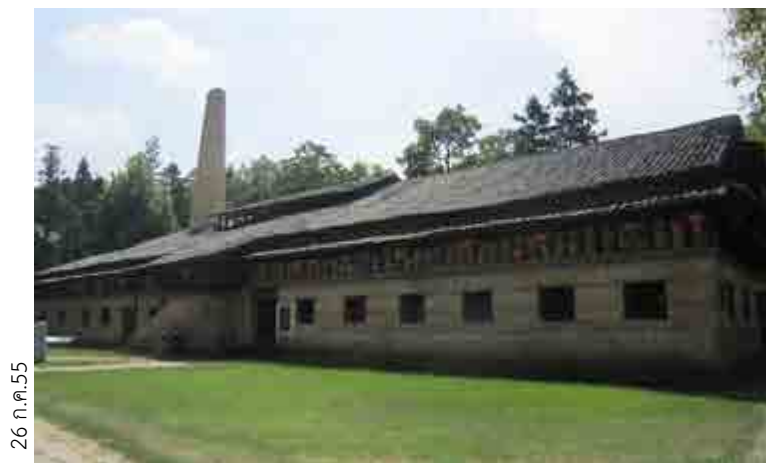
ภาพที่ 4.11 : เตาเผาเจิ้นจะอยู่ภายในเรือนเตา เตาเผาแบบประเพณีของจีนชนิดแบบที่มีปล่องเตาจะอยู่ในเรือนเตาทั้งสิ้น ซึ่งจะแตกต่างจากเตามังกรที่ใช้ทำเลภูมิศาสตร์ในการก่อเป็นเตาเผา
