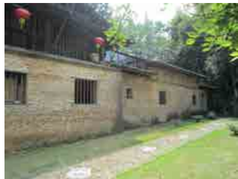
ภาพที่ 5.10 : อาคารเตาอนุรักษ์ของเตาเผาเงินเป็นเรือนที่มีโครงสร้างด้วยไม้และมุงด้วยกระเบื้อง ภายในมีสองชั้น ตัวเตาจะอยู่ภายใน ชั้นที่สองรายรอบของเรือนเตาเป็นที่เก็บไม้ฟืน ชั้นล่างเป็นที่ จัดเก็บหีบหนไฟ (saggar) สำหรับบรรจุภาชนะก่อนนำเข้าเตาเผา เตาเงินเป็นเตารูปทรงไข่ที่มี เทคโนโลยีที่ดีที่สุดในแบบของเตาเผาเชิงประเพณีที่ใช้ฟืนเป็นเชื้อเพลิง ได้รับการขึ้นทะเบียนจากหน่วย อนุรักษ์โบราณวัตถุสำคัญของมณฑล โดยรัฐบาลมณฑลเจียงซี เมื่อ 25 กรกฎาคม ค.ศ. 2000
