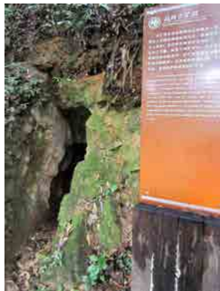
ภาพที่ 5.31 : ช่องอุโมงค์เก่าที่เจาะจากรอยแตกของหิน เจาะช่องเข้าไปเป็นช่องสามเหลี่ยม เมื่อพบว่าตรงจุดไหนมีแร่เกาลินมากจะทำการเปิดหน้าเหมืองออกเป็นบริเวณกว้าง ตำแหน่งเจาะช่องหินต่างๆ ได้พัฒนาเป็นแหล่งศึกษาและเรียนรู้ โดยมีป้ายนิทรรศน์แสดงข้อมูลอยู่ทุกจุด
