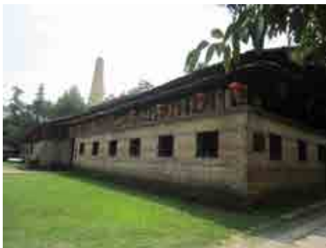
ภาพที่ 5.10 : อาคารเตาอนุรักษ์ของเตาเผาเงินเป็นเรือนที่มีโครงสร้างด้วยไม้และมุงด้วยกระเบื้อง ภายในมีสองชั้น ตัวเตาจะอยู่ภายใน ชั้นที่สองรายรอบของเรือนเตาเป็นที่เก็บไม้ฟืน ชั้นล่างเป็นที่ จัดเก็บหีบหนไฟ (saggar) สำหรับบรรจุภาชนะก่อนนำเข้าเตาเผา เตาเงินเป็นเตารูปทรงไข่ที่มี เทคโนโลยีที่ดีที่สุดในแบบของเตาเผาเชิงประเพณีที่ใช้ฟืนเป็นเชื้อเพลิง ได้รับการขึ้นทะเบียนจากหน่วย อนุรักษ์โบราณวัตถุสำคัญของมณฑล โดยรัฐบาลมณฑลเจียงซี เมื่อ 25 กรกฎาคม ค.ศ. 2000
