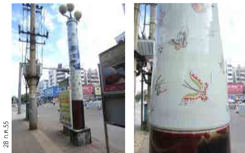
ภาพที่ 5.46 : ปelokกระเบื้องหุ้มเสาไฟฟ้าทั้งเมืองจิ่งเต๋อเจิ้น ที่มีการออกแบบลักษณะและลวดลายตกแต่งหลากหลาย โดยได้รับความร่วมมือจากภาคเอกชนร่วมผลิตปelokกระเบื้องนี้ นอกจากความสวยงามแล้วยังเป็นฉนวนไฟฟ้าและกันงูเลื้อยขึ้นเสาไฟฟ้าได้ดี มีความคงทนสูงเพราะเป็นเนื้อระดับ hi-porcelain
