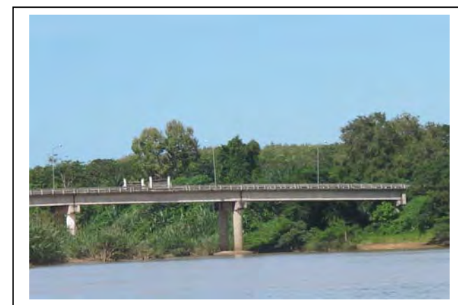
สถานี PD 5 : สะพานพุมดวง (หน้าโรงงานสุรา) อ.พุนพิน
