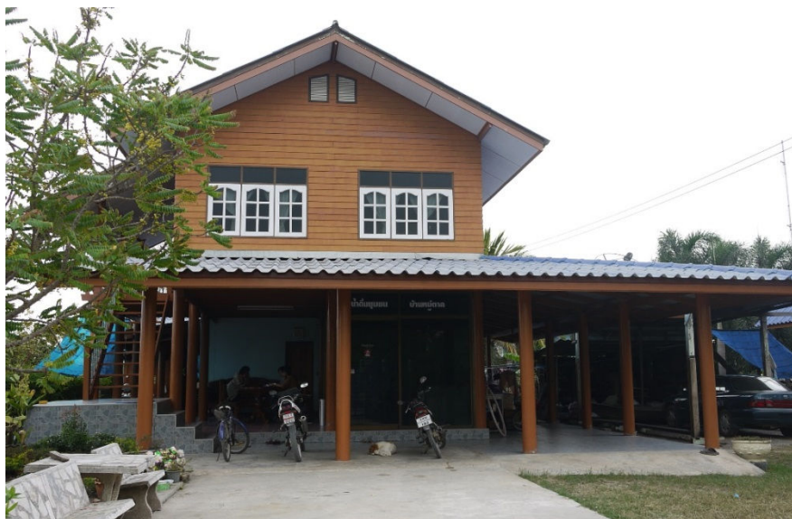
รูปที่ 7.12 บ้านสองชั้นไม้ชั้นบนปูนชั้นล่าง
