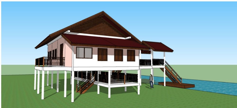
รูปที่ 7.23 บ้านปูนชั้นเดียวมีใต้ถุนสร้างสูงกว่า 2.50 เมตร อาจเพิ่มพื้นที่เอนกประสงค์ในส่วนใต้ถุน
