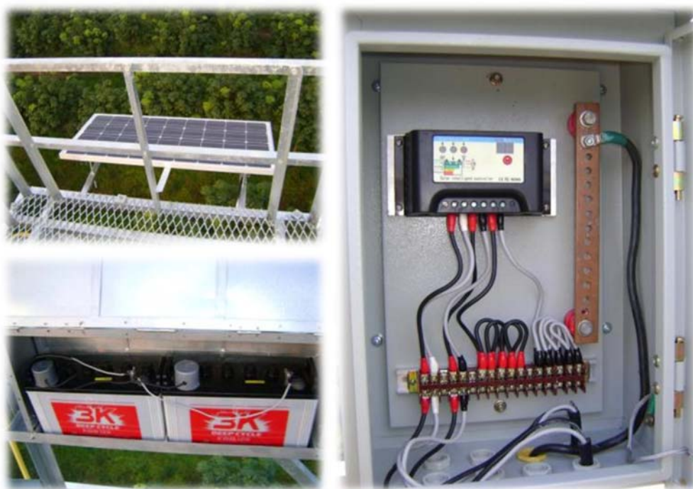
รูปที่ 2-9 การติดตั้งระบบ Solar panel บนหอคอย ณ พื้นที่ศึกษา Site ที่ 2 สวนยางพาราของเกษตรกร อำเภopakคาคัด จังหวัดบึงกาฬ
