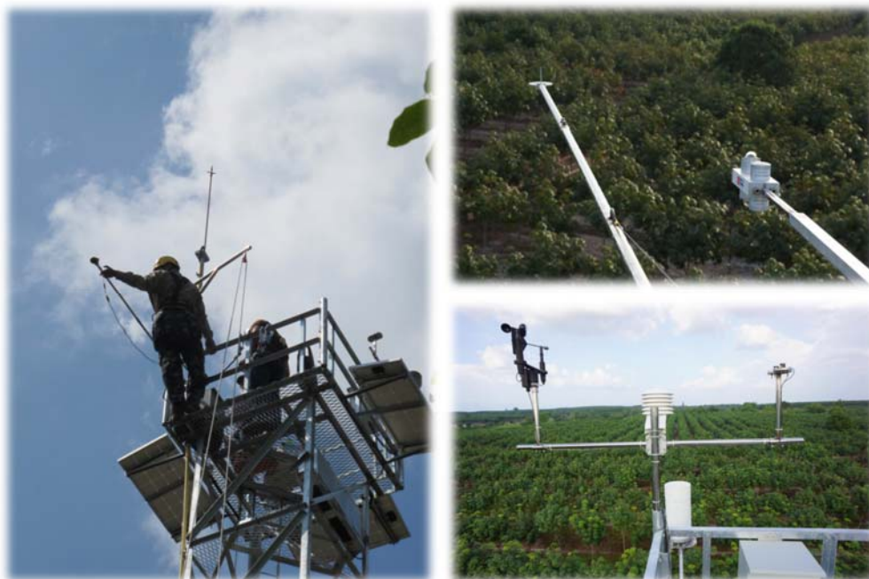
รูปที่ 2-8 การติดตั้งชุดอุปกรณ์ตรวจวัดสภาพภูมิอากาศ ณ พื้นที่ศึกษา Site ที่ 2 สวนยางพาราของเกษตรกร อำเภopakคาคัด จังหวัดบึงกาฬ
