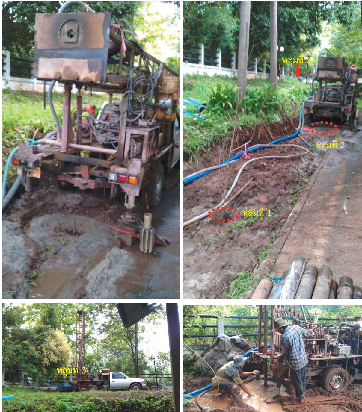
ภาพที่ 4-32 ตำแหน่งการจุดเจาะน้ำใต้ดินทั้งหมด 3 ตำแหน่งและการวางเครื่องเจาะซึ่งจุดเจาะที่ 3 มีการขยับเปลี่ยนตำแหน่งหลายครั้งเนื่องจาก พบชั้นตะกอนเศษหินเชิงเขาและไม่สามารถเจาะต่อได้
