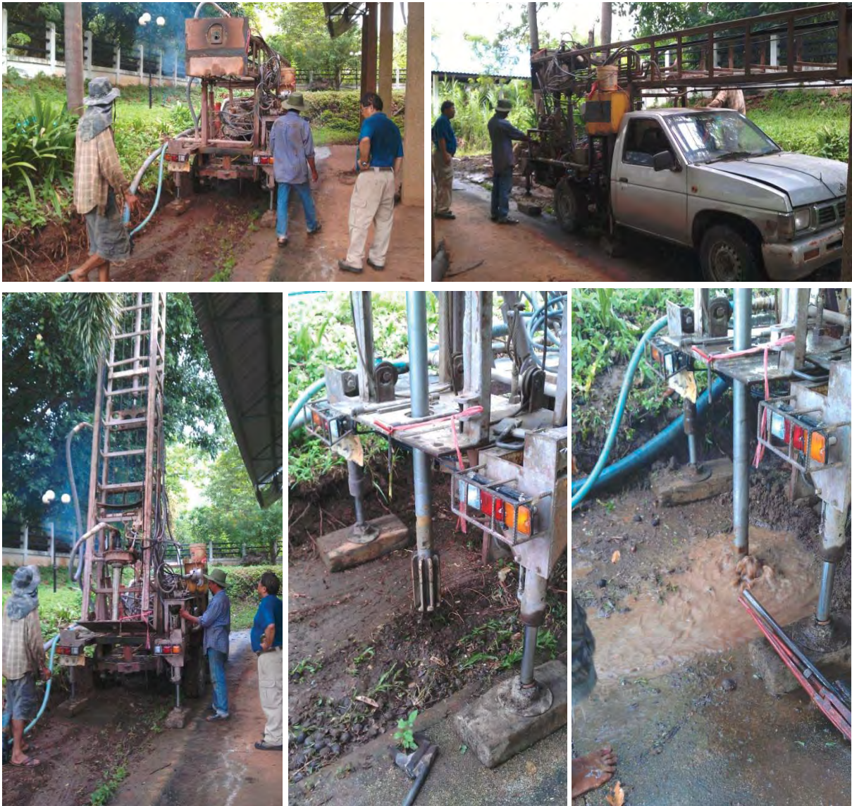
ภาพที่ 3-15 เครื่องเจาะที่ใช้เป็นแบบเฉพาะ คือมีขนาดเล็ก สามารถเข้าเจาะบริเวณที่แคบ บริเวณที่ก่อสร้าง แหล่งท่องเที่ยวได้ และสามารถขยับย้ายตำแหน่งการเจาะสะดวก จากภาพเป็นการย้ายและตั้งเครื่อง เจาะ ณ ตำแหน่งที่ 2
