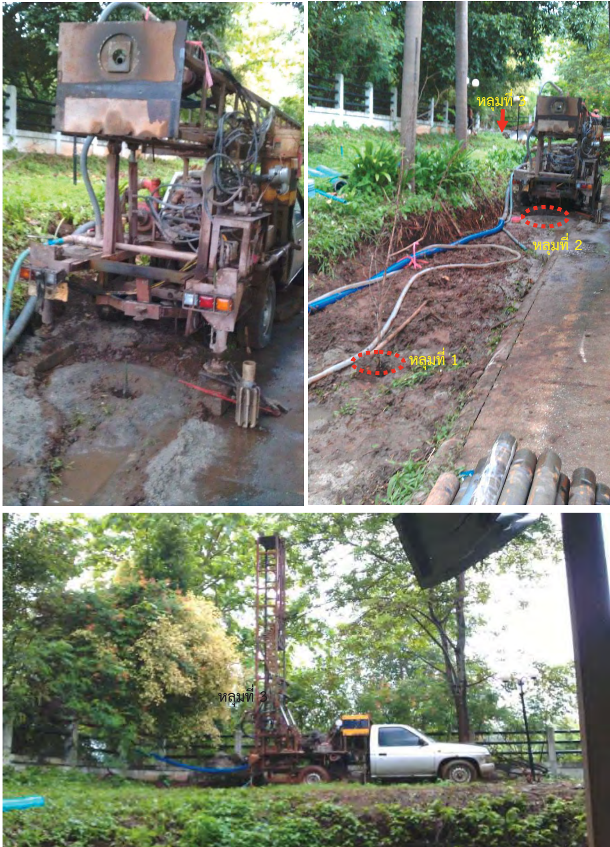
ภาพที่ จ ตำแหน่งการเจาะน้ำใต้ดินทั้งหมด 3 ตำแหน่งและการวางเครื่องเจาะซึ่งจุดเจาะที่ 3 มีการ ขยับเปลี่ยนตำแหน่งหลายครั้งเนื่องจาก พบชั้นตะกอนเศษหินแข็งเขาไม่สามารถเจาะต่อได้
