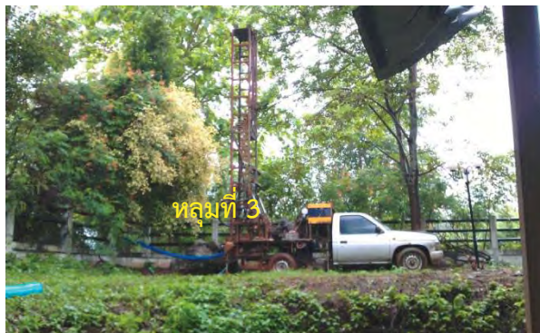
ภาพที่ 4-32 ตำแหน่งการจุดเจาะน้ำใต้ดินทั้งหมด 3 ตำแหน่งและการวางเครื่องเจาะซึ่งจุดเจาะที่ 3 มีการขยับเปลี่ยนตำแหน่งหลายครั้งเนื่องจาก พบชั้นตะกอนเศษหินเชิงเขาและไม่สามารถเจาะต่อไปได้
