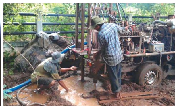
ภาพที่ 4-32 ตำแหน่งการจุดเจาะน้ำใต้ดินทั้งหมด 3 ตำแหน่งและการวางเครื่องเจาะซึ่งจุดเจาะที่ 3 มีการขยับเปลี่ยนตำแหน่งหลายครั้งเนื่องจาก พบชั้นตะกอนเศษหินเชิงเขาและไม่สามารถเจาะต่อไปได้
