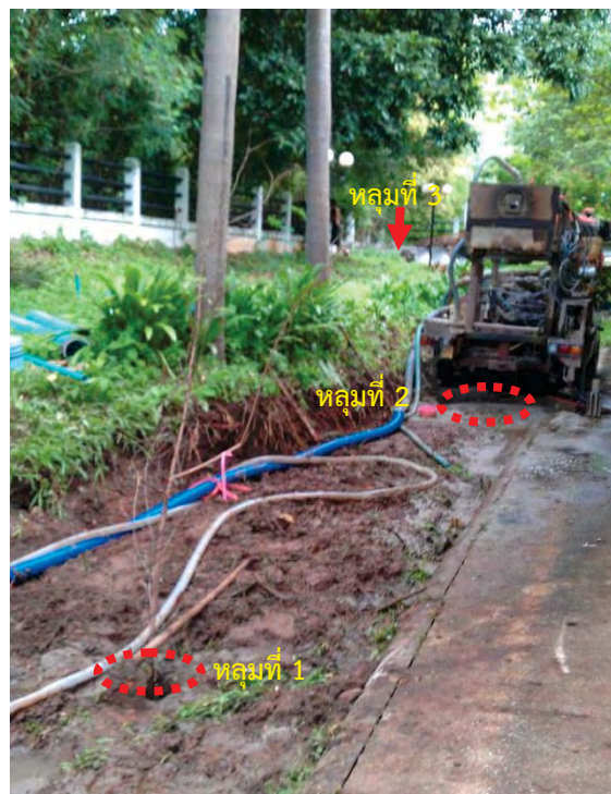
ภาพที่ ก-9 ตำแหน่งการจุดเจาะน้ำใต้ดินทั้งหมด 3 ตำแหน่งและการวางเครื่องเจาะซึ่งจุดเจาะที่ 3 เมื่อ การขยับเปลี่ยนตำแหน่งหลายครั้งเนื่องจาก พบชั้นตะกอนเศษหินผุเชิงเขาไม่สามารถเจาะต่อได้
