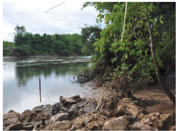
ภาพที่ 4-33 บริเวณริมตลิ่งมีการวางแนวหินทิ้งเพื่อ ป้องกันการกัดเซาะ
