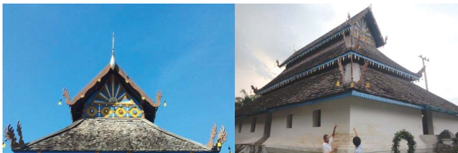
ภาพที่ 18 บริเวณหน้าบันวัดตันแหลง และรูปทรงหลังคาซ้อนกัน 3 ชั้น แสดงถึงศิลปะไทลื้อ
