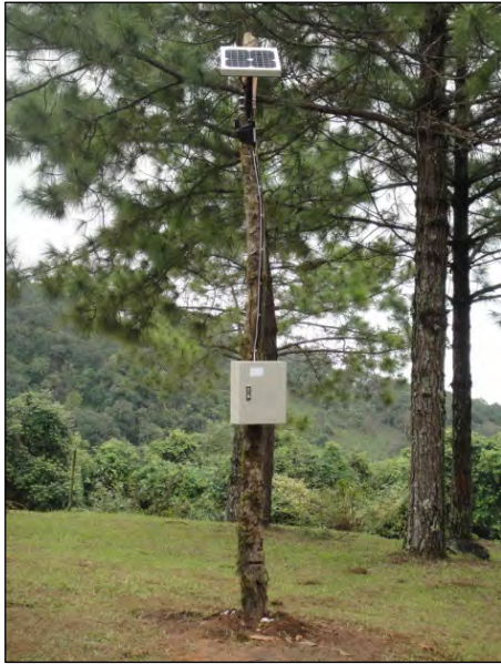
ภาพที่ ๔.๑๒ แสดงตัวอย่างรูปแบบระบบผลิตกระแสไฟฟ้าด้วยพลังงานแสงอาทิตย์สำหรับ ลานจอดรถยนต์
