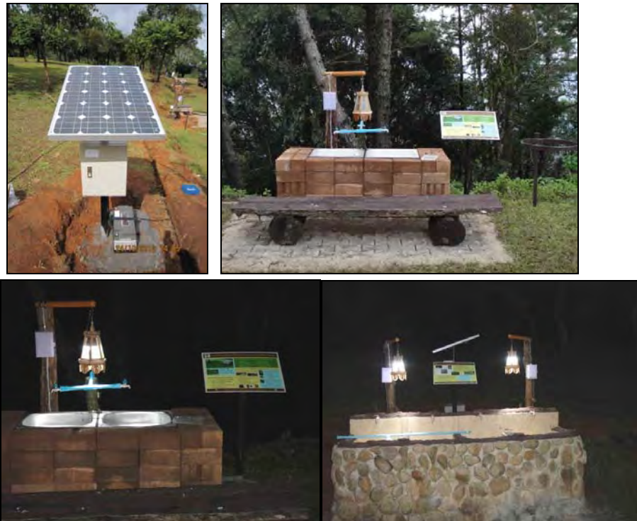
ภาพที่ ๔.๑๓ แสดงตัวอย่างรูปแบบระบบผลิตกระแสไฟฟ้าด้วยพลังงานแสงอาทิตย์ สำหรับลานทางเดิน
