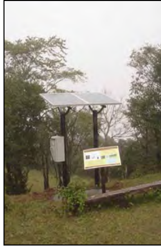
ภาพที่ ๔.๑๔ แสดงตัวอย่างรูปแบบระบบผลิตกระแสไฟฟ้าด้วยพลังงานแสงอาทิตย์ สำหรับห้องน้ำ - ห้องสุขา
