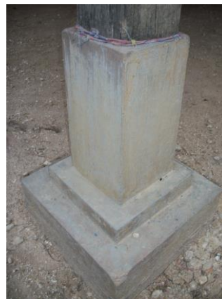
รูปภาพที่ 4.67 ฐานเสาเรือนคอนกรีต
