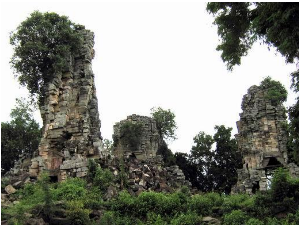
รูปภาพที่ 4.63 ปราสาทบันทายทัฟ หมู่ปราสาท 5 หลังที่พังทลาย มีร่องรอยของเครื่องไม้เครื่องมือโบราณหลงเหลืออยู่เพียงแห่งเดียวในกัมพูชา
