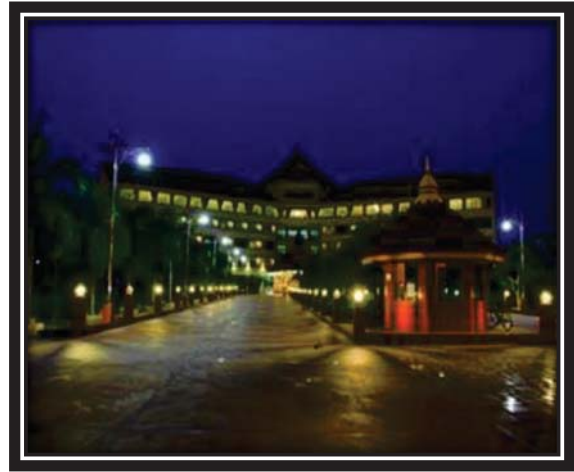
ภาพที่ 188 อาคารของโรงแรมจากด้านหน้า
