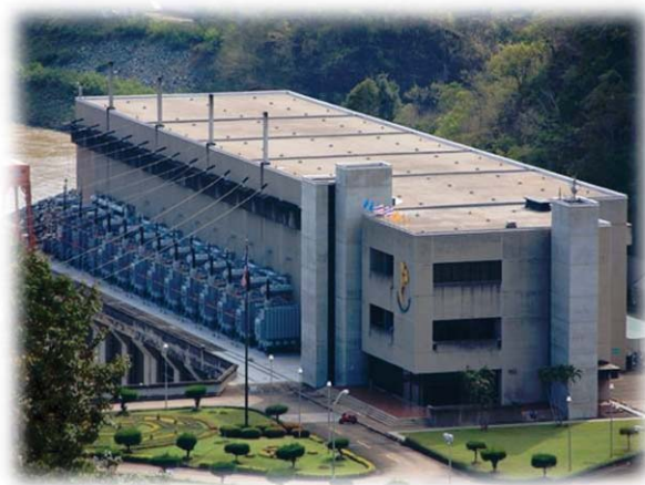
ภาพ ก-8 โรงผลิตไฟฟ้า เขื่อนสิริกิติ์
