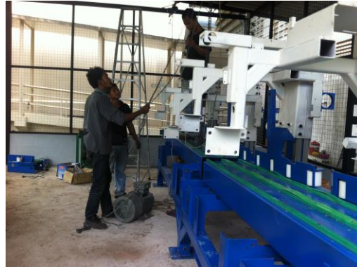
รูปที่ 5.2 แสดงการติดตั้งชุดมอเตอร์ทั้ง 4 ชุด
