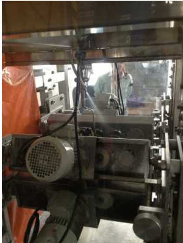
รูปที่ 31 การติดตั้งเครื่องทดสอบ
