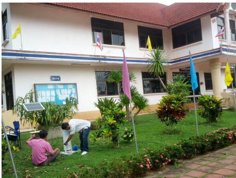
รูปที่ 4.40 การติดตั้งเครื่องมือวัดปริมาณน้ำฝน
