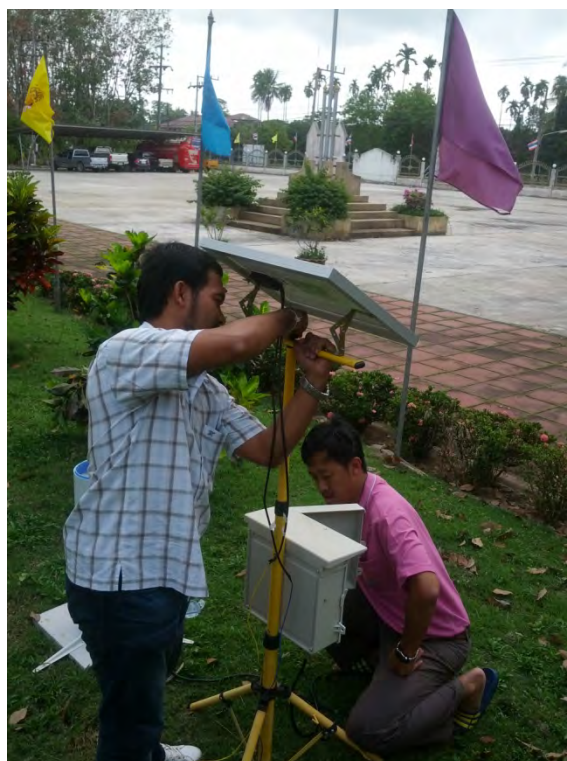
รูปที่ 4.40 การติดตั้งเครื่องมือวัดปริมาณน้ำฝน
