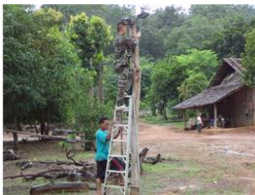
ภาพที่ 3-32 กำลังพลร่วมกับชาวบ้าน เดินสายไฟหลักสำหรับต่อโคมไฟถนนในหมู่บ้าน
