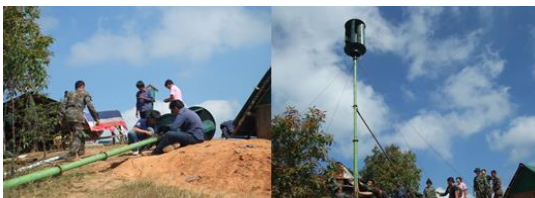
ภาพที่ 3-14 ติดตั้งกังหันลมกังหันSAVONIUS ชนิด 5 กليبใบที่ออกแบบและพัฒนาครีบริบเสริมความแข็งแรงของใบกังหัน
