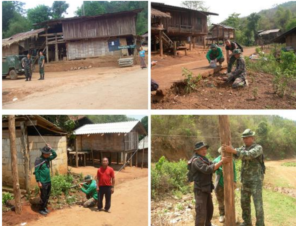
ภาพที่ 3-34 กำลังพลและชาวบ้านดำเนินการวางตำแหน่งเสาไฟฟ้าถนนในหมู่บ้าน
