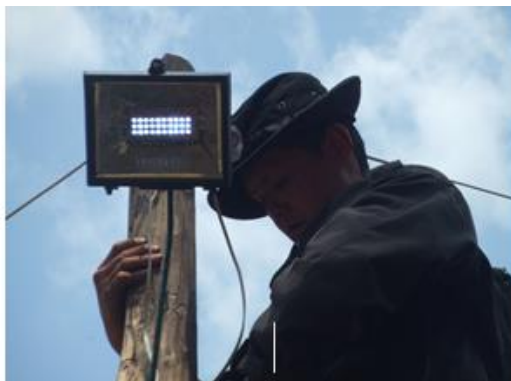
ภาพที่ 3-38 คอมไฟส่องสว่าง High power LED ถนนภายในหมู่บ้านจากไฟฟ้า 12 โวลต์
