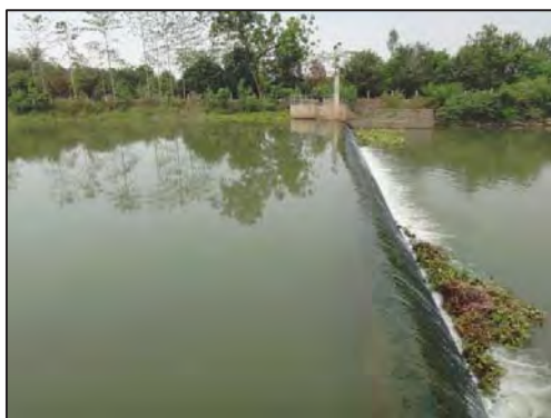
ลักษณะของฝายและท่อระบายน้ำฝิ่งตะวันออก (ฝายวังพาน) ซึ่งทำได้ยากในฝิ่งตะวันตก เนื่องจากข้อจำกัดด้านที่ดิน และลักษณะทางภูมิศาสตร์
