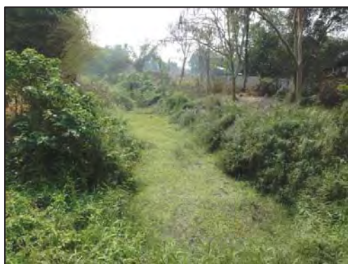
จุดสำรวจคลองสวนหมาก หลังวัดสว่างอารมณ์ พิกัด 552508, 1822818 แหล่งน้ำตื้นเขิน มีวัชพืชปกคลุม มีน้ำบ้างเล็กน้อย แต่เป็นลักษณะของน้ำนิ่ง ไม่มีการไหล
