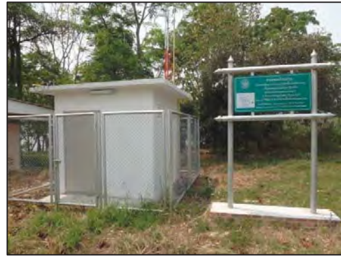
โครงการวางระบบและติดตั้งระบบโทรมาตรเพื่อ พยากรณ์น้ำและเตือนภัย สถานีอ่างเก็บน้ำคลองมดแดง
