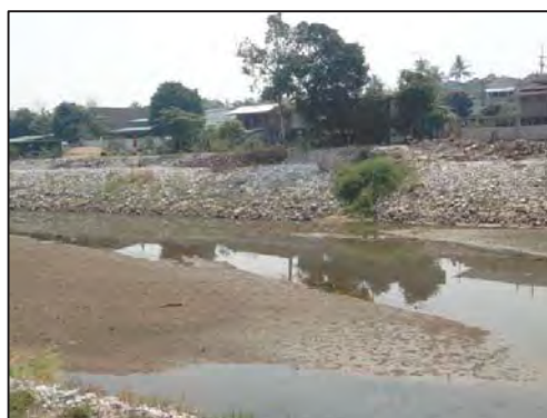
จุดสำรวจคลองสวนหมาก หน้าวัดสว่างอารมณ์ พิกัด 552744, 1822798 แหล่งน้ำตื้นเขิน มองเห็นพื้นที่ตื้นน้ำไหลช้า และมีภาวะเสี่ยงต่อการแห้งขอด
