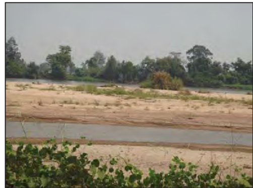
จุดสำรวจสะพานข้ามแม่น้ำปิง บ้านอำมรงค์ พิกัด 570396, 1806451 สภาพแม่น้ำแห้งขอด มีน้ำน้อย
