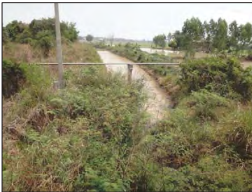
จุดสำรวจคลองโพรง พิกัด 574752, 1793810 มีน้ำไหลเนื่องจากมีการขุดคลองคู่คลองในช่วงแล้ง เพื่อกักเก็บน้ำ
