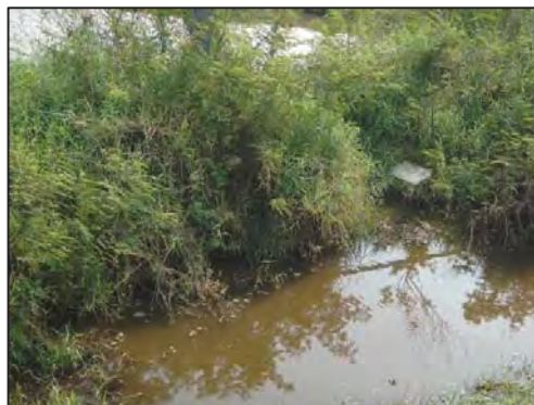
สภาพคลองหนองขำรูด บริเวณจุดสำรวจ มีน้ำเล็กน้อย พื้นที่คลองถูกปล่อยให้อยู่ในสภาพกร้าง แต่มีการขุดลอกเป็นระยะ
